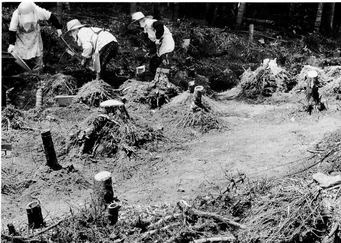
1号墳丘表土除去作業風景（南西から）
