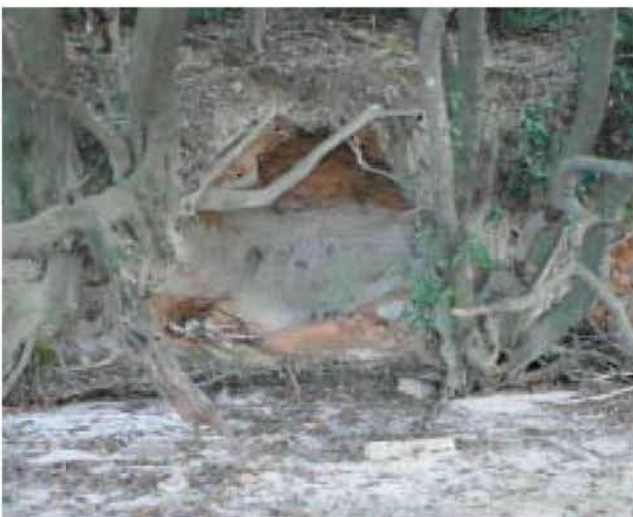
5. 第2次調査地点から北西の崖下(西から) 野多目池の端で撮影。野多目池の水の影響でえぐられ、 丘陵の岩盤が露出している。
