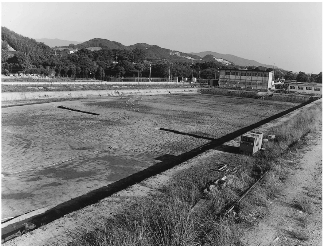
(2) 第Ⅱ面南半全景（北から）
