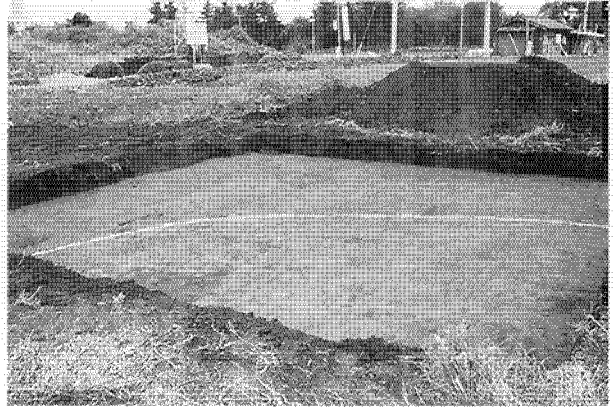
遺構確認の状況
