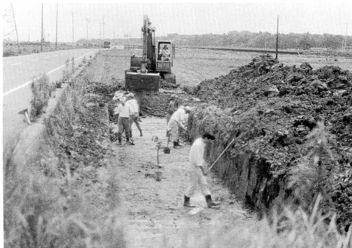
口北台遺跡調査風景（西から）
