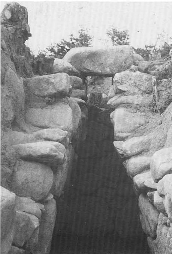
1号墳石室（南から）
