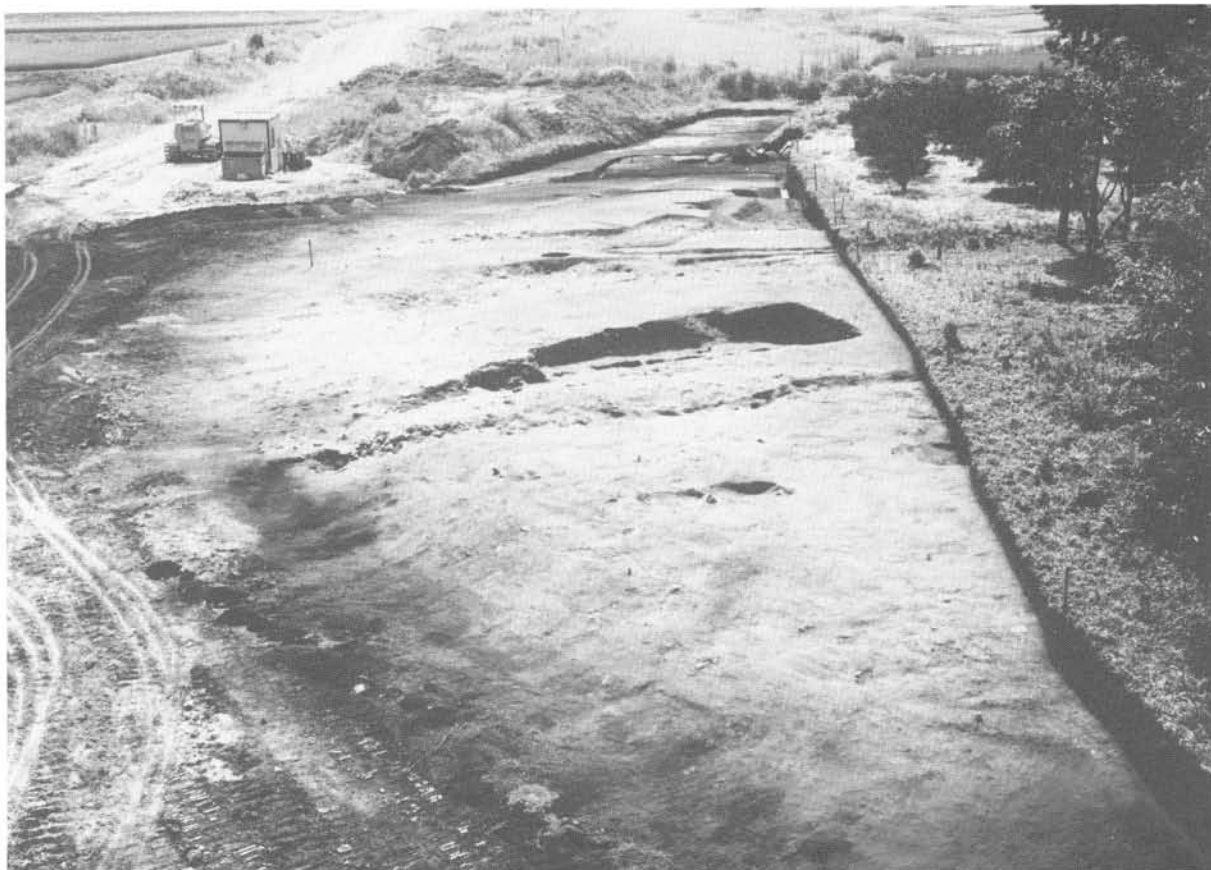
昭和61年度調査区全景（北東から）
