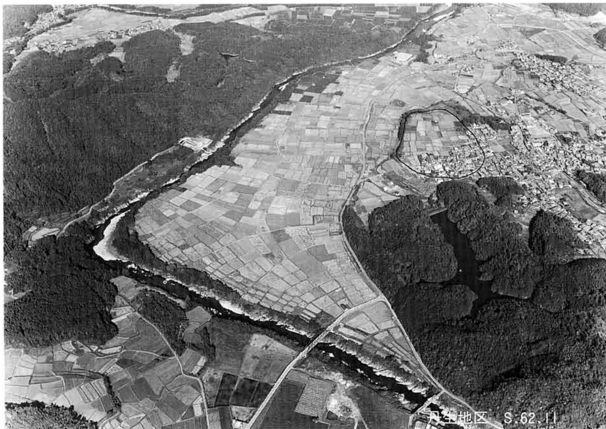
圃場整備前の丹生地区(南から) (松阪農林事務所提供)
