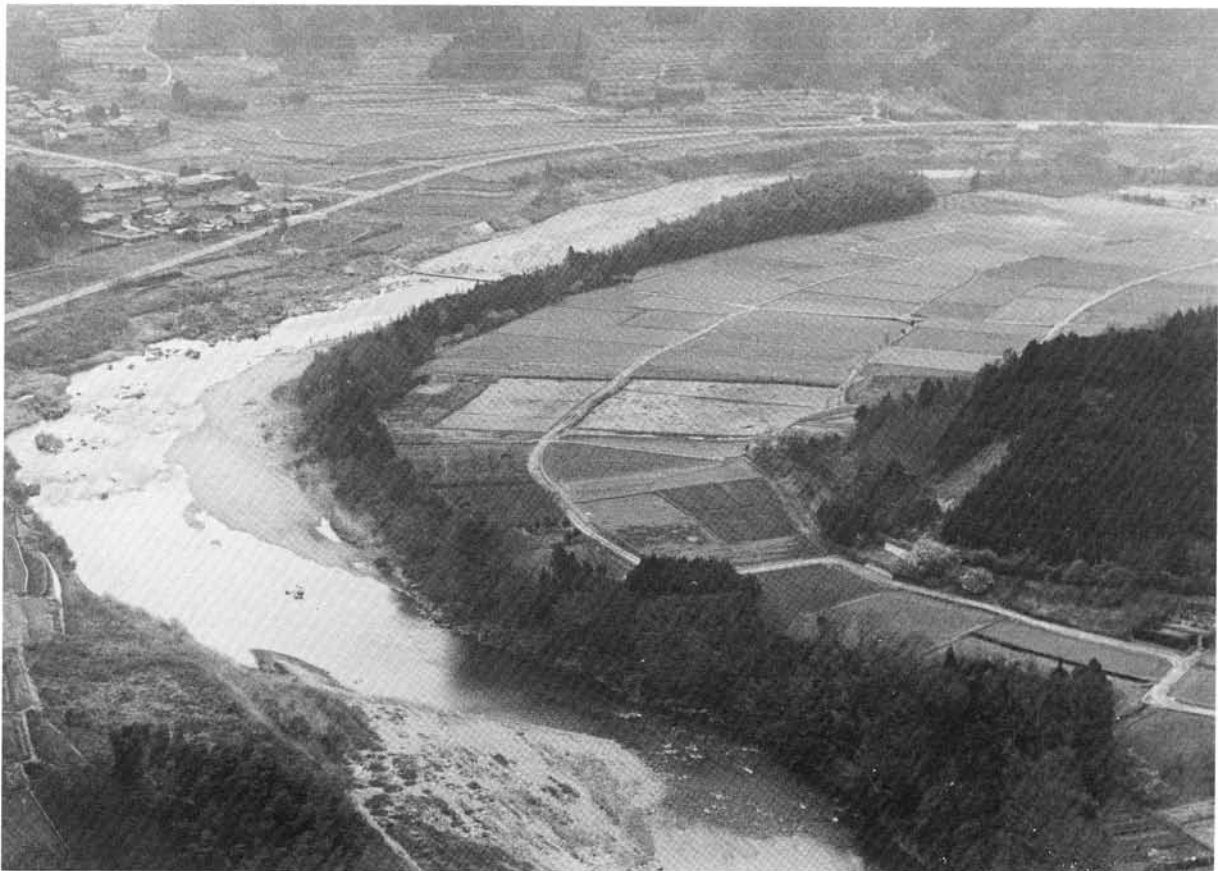
調査後遠景（南西上空から）
