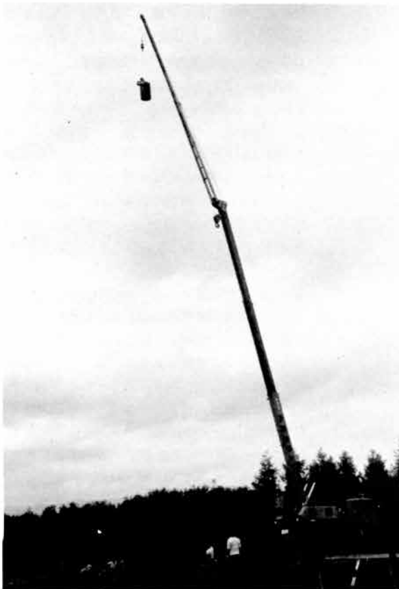
挿図2 調査風景(写真撮影)
