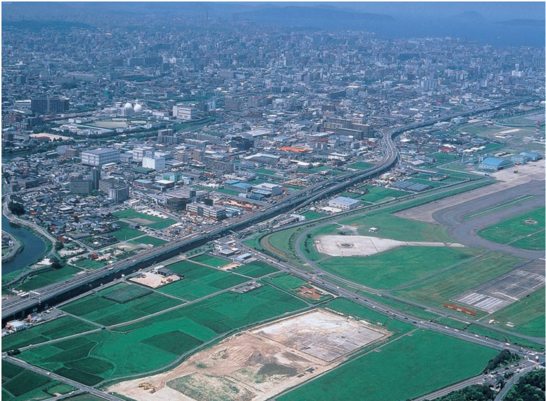
(2) 調査地南東側から福岡市街を臨む
