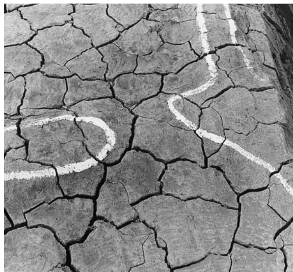
(1) SS349水口 (西から)
