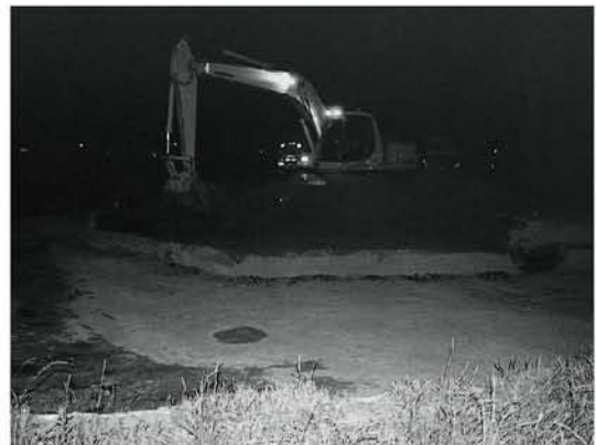
写真② 夜間作業風景
