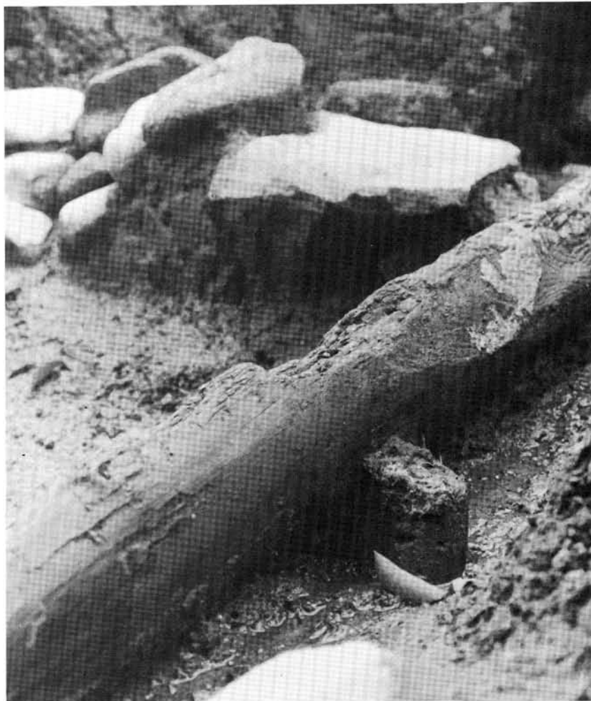
堰東端部（南西から）
