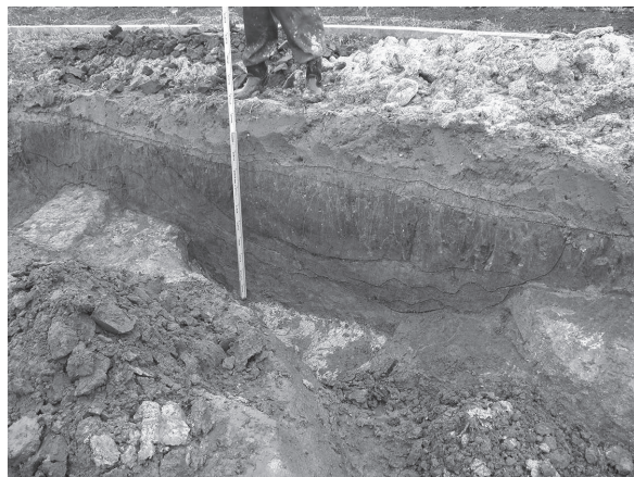
2 NR01 断ち割り状況 (南西から)
