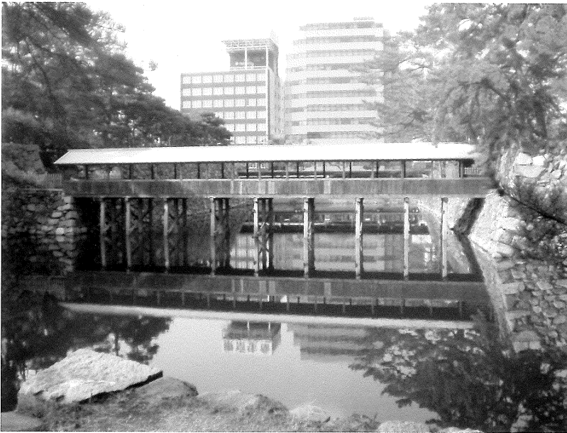
写真3 解体前の鞆橋①（東面）
