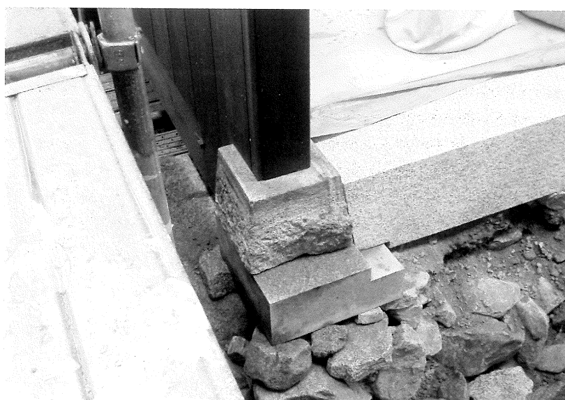
写真 5 6 柱礎石 (再用材) 施工状況
