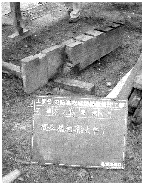
写真23 既存橋桁撤去（西端）
