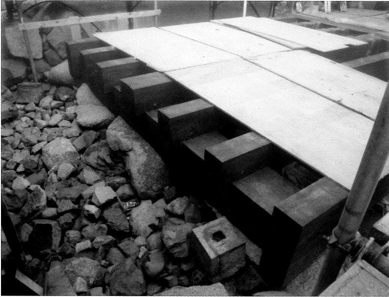
写真39 敷土台・橋桁設置状況
