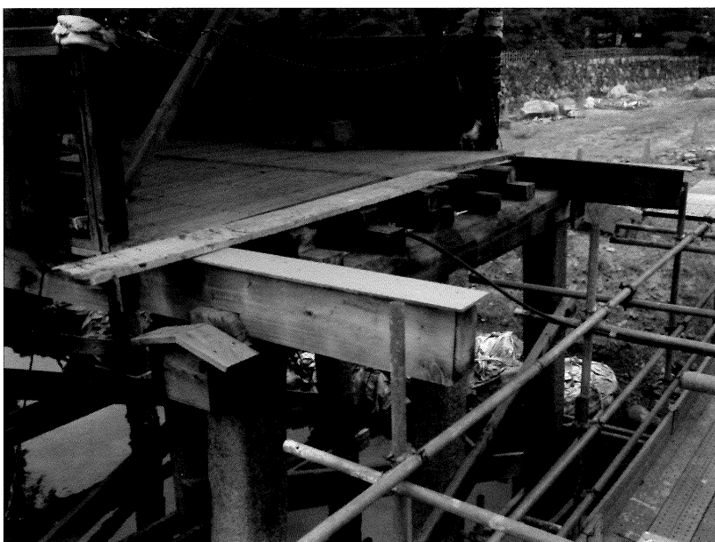
写真1 4 解体後修理前の状況③ 既存継手
