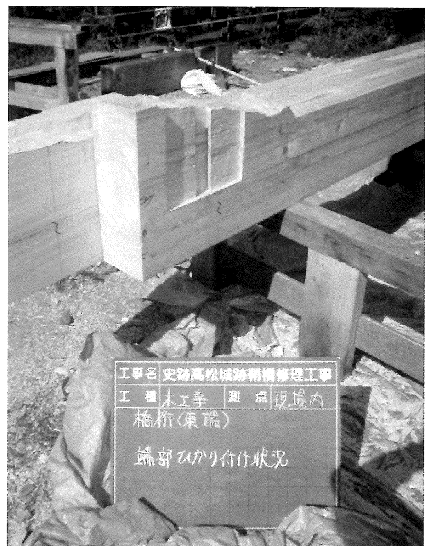
写真32 橋桁(東側南端) 敷土台との仕口(蟻継ぎ)および石垣へのひかり付け加工状況
