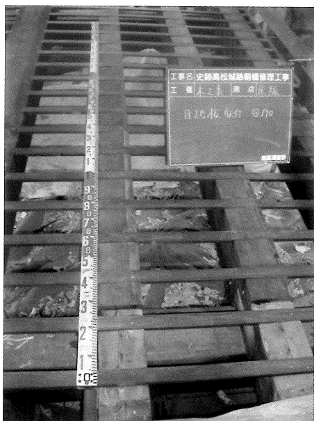
写真 5 1 床部目地板取付状況
