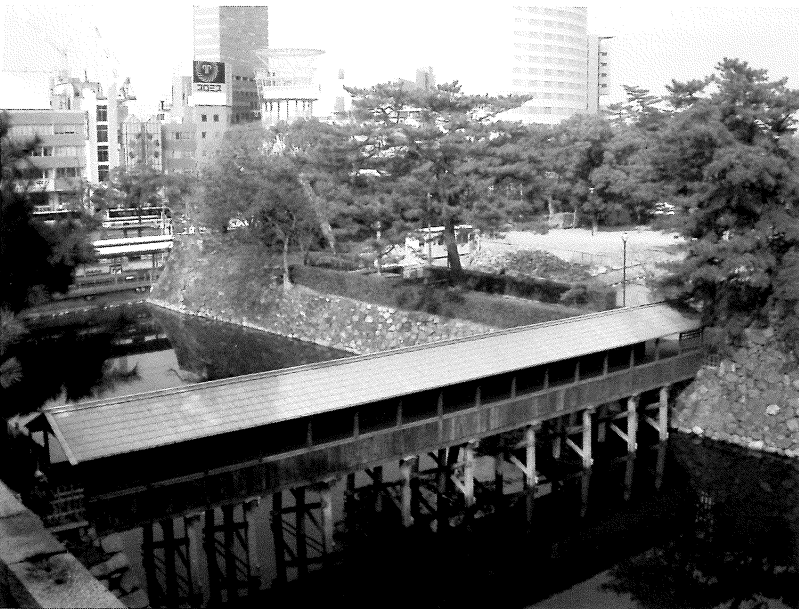
写真4 解体前の鞆橋②（東面）
