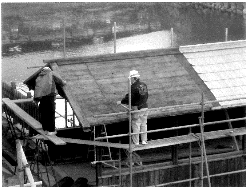
写真6 解体中の鞆橋①
