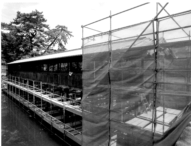
写真19 ブラケット足場設置状況①
