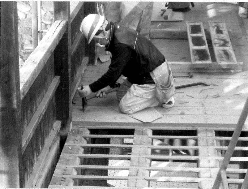
写真10 解体中の鞘橋⑤
