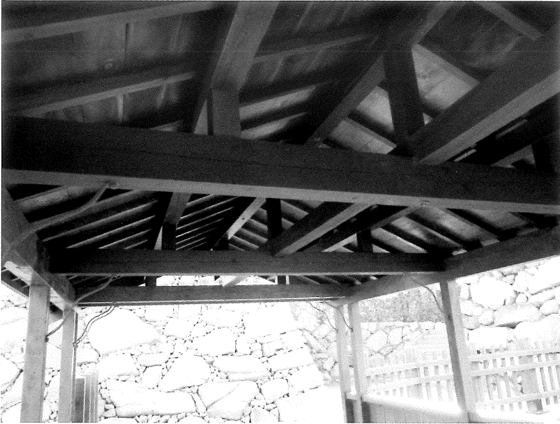
写真7 2 竣工鞆橋小屋組
