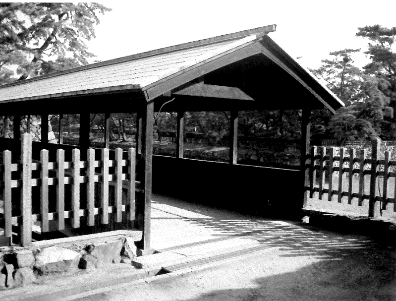
写真5 解体前の鞆橋③（南面）
