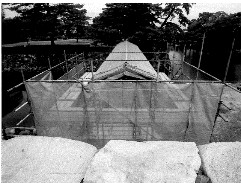
写真20 ブラケット足場設置状況②
