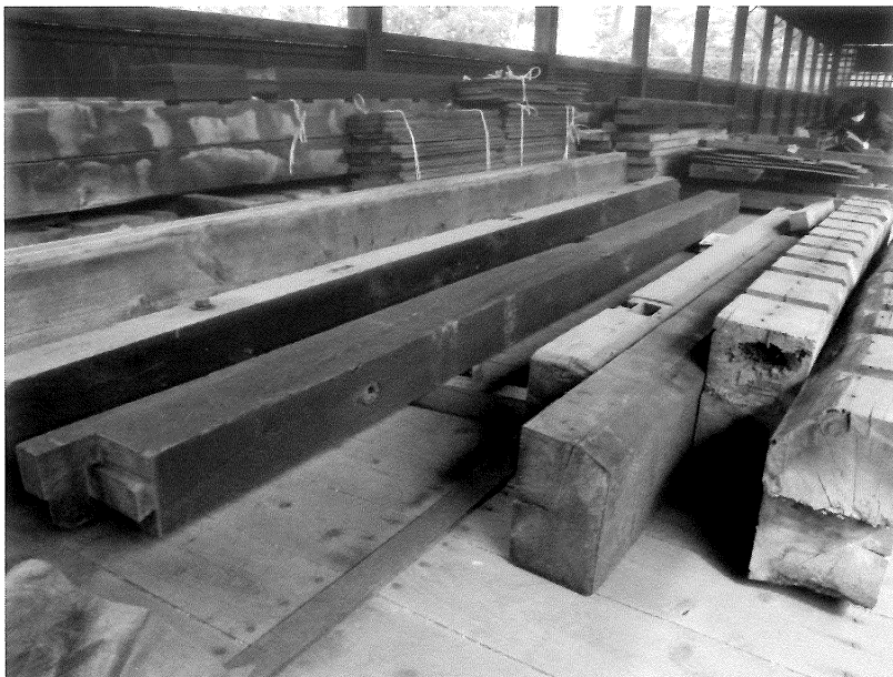
写真18 解体後修理前の状況⑦ 解体部材
