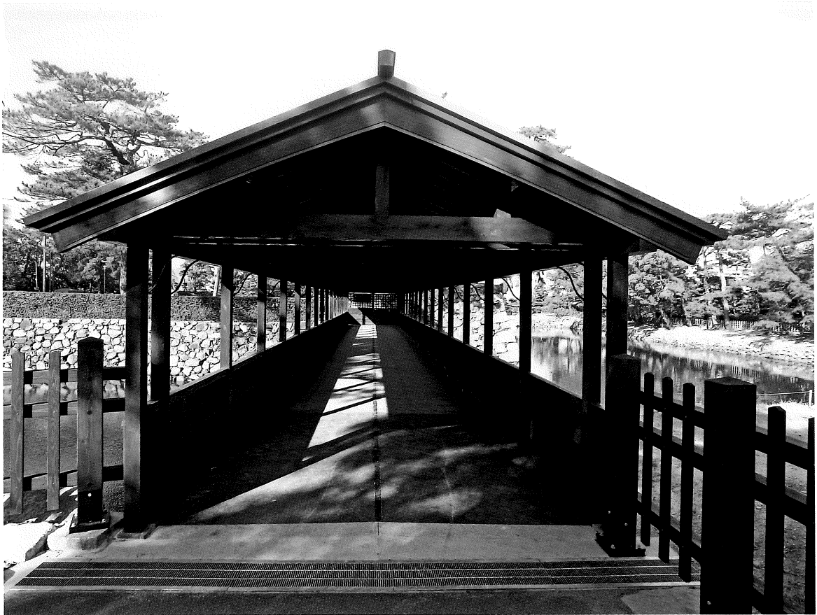
竣工鞆橋南面
