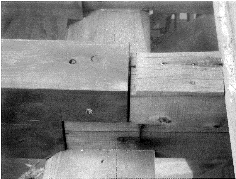
写真36 橋桁（その他）既存側継手部施工状況
