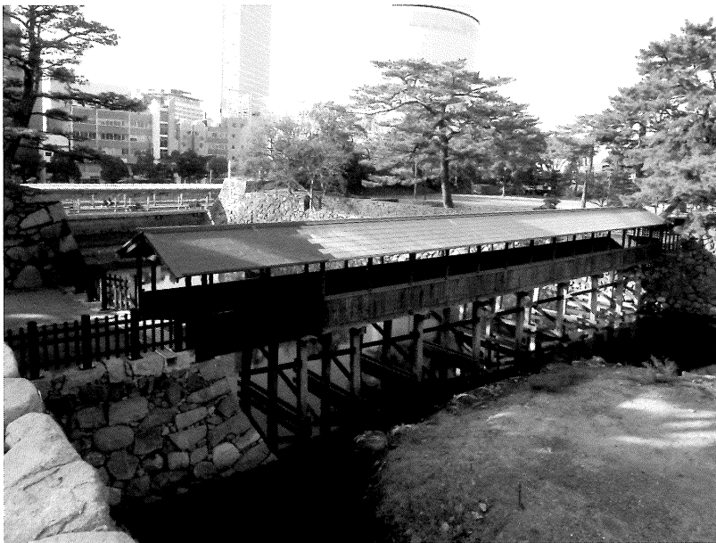
写真70 竣工鞆橋東面②
