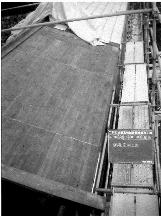
写真49 野地板施工状況
