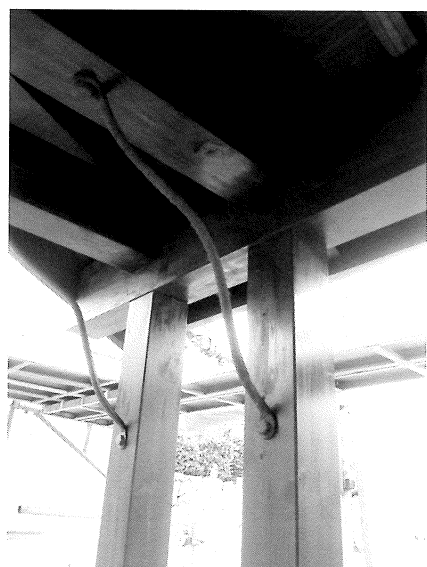
写真 5 5 梁支持金物施工状況
