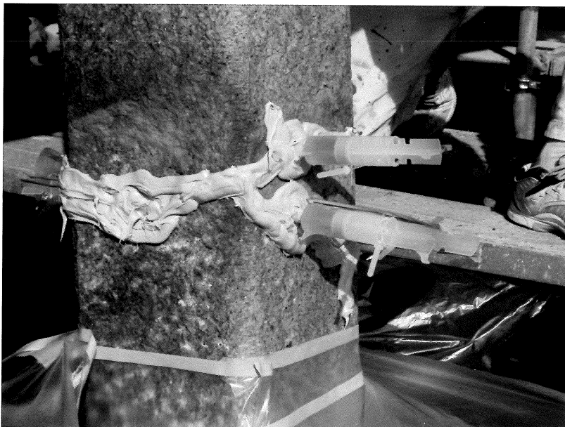
写真62 ボンドシリンダー工法 エポキシ樹脂注入状況
