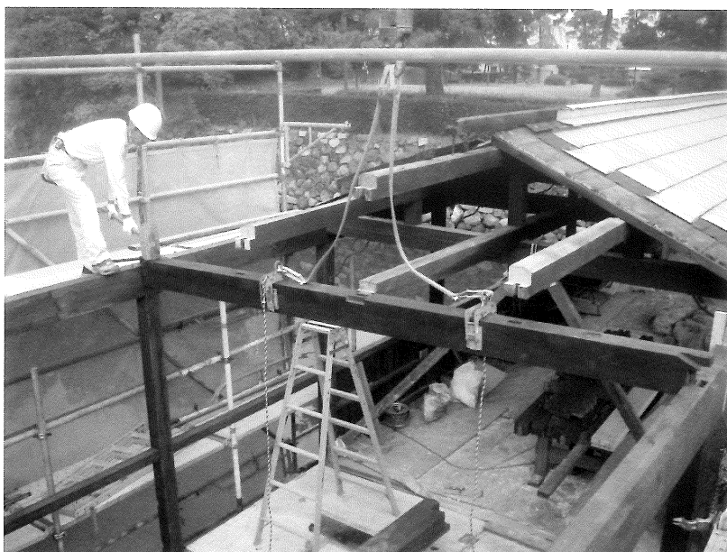
写真4 3 木造橋部分軸組建方
