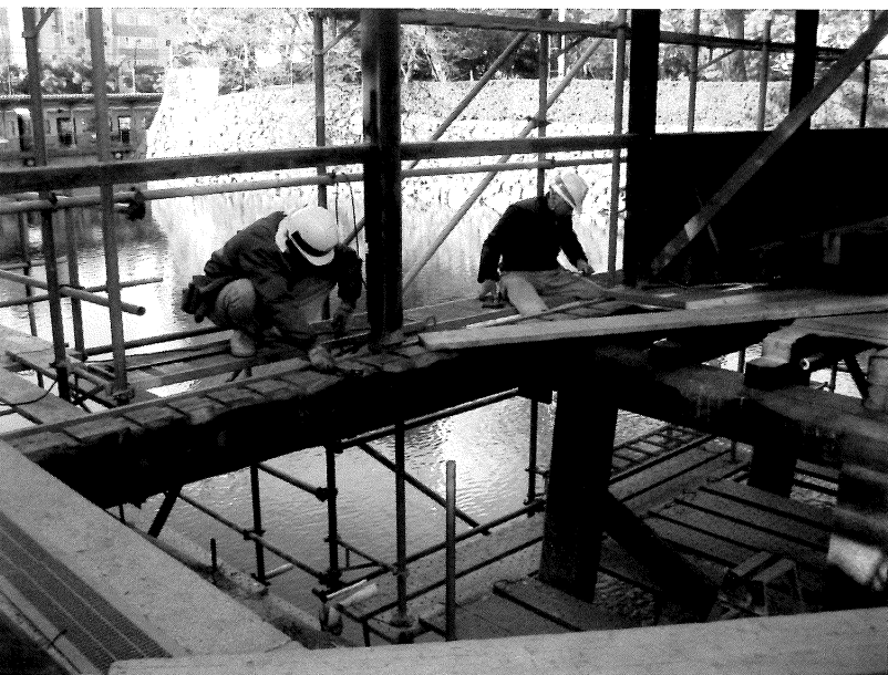
写真11 解体中の鞘橋⑥
