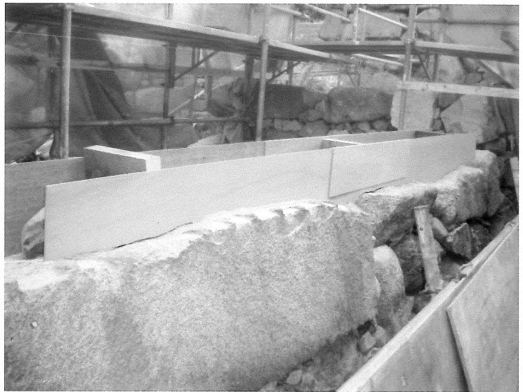
写真25 敷土台型板製作状況②
