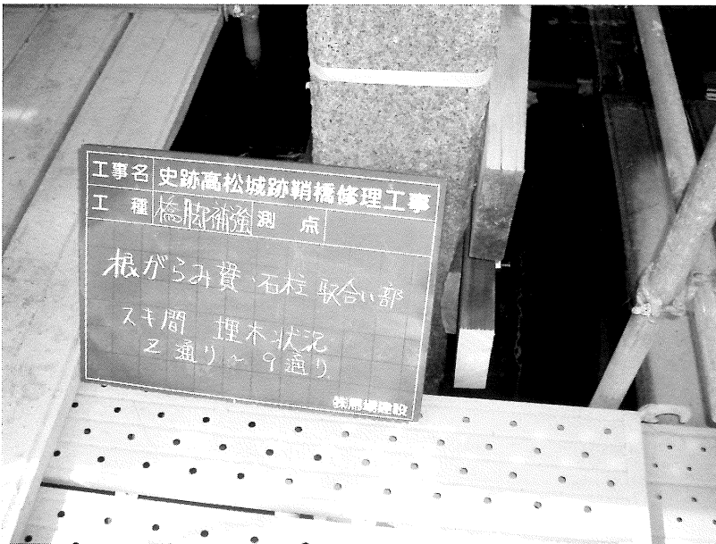
写真67 石柱・根がらみ貫取り合い部埋木状況
