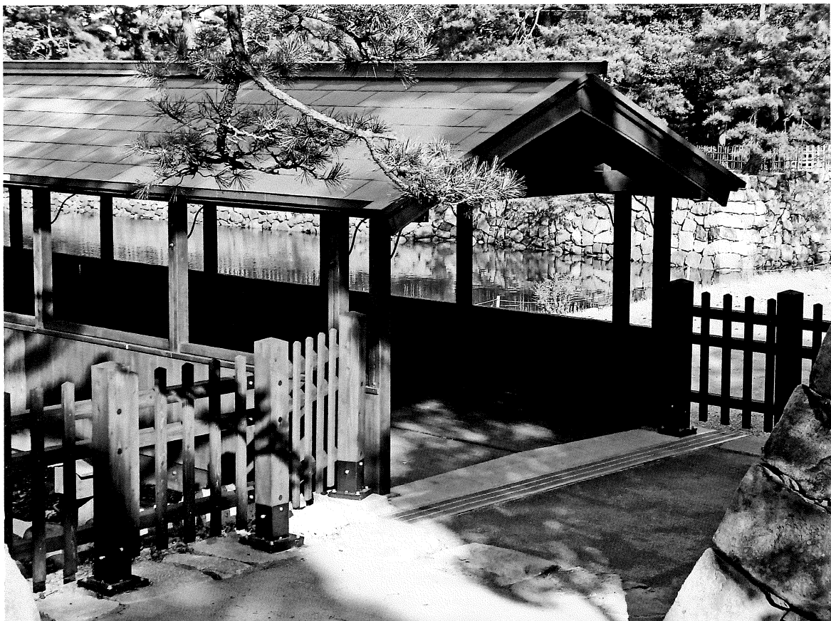
竣工鞆橋木造橋部修理部分
