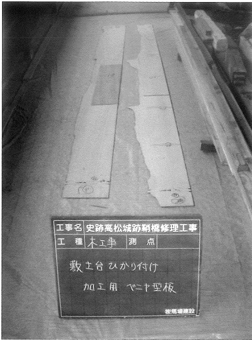
写真24 敷土台型板製作状況①
