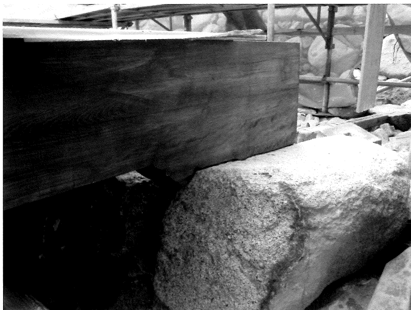
写真38 橋桁（西端）南端ひかり付け施工状況
