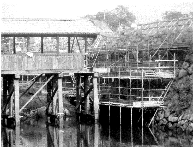
写真1 2 解体後修理前の状況① (西面)
