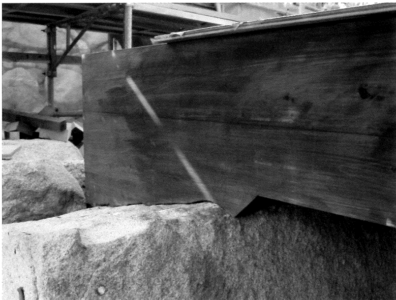
写真37 橋桁（東端）南端ひかり付け施工状況
