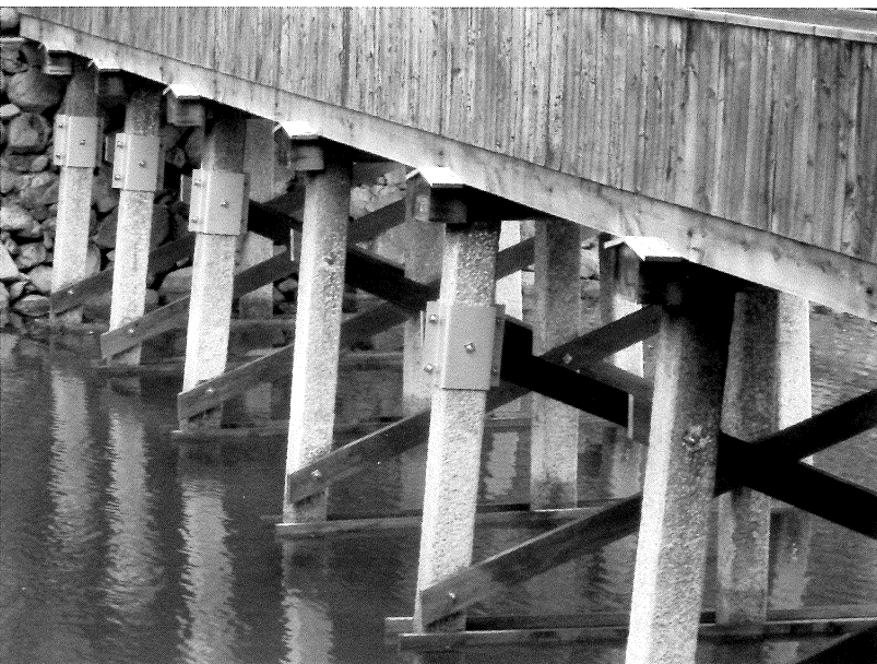
写真7 4 橋脚補修・根がらみ貫新設
