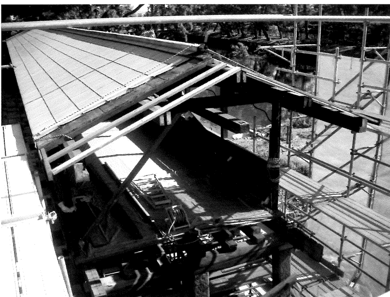
写真1 3 解体後修理前の状況② (南面)
