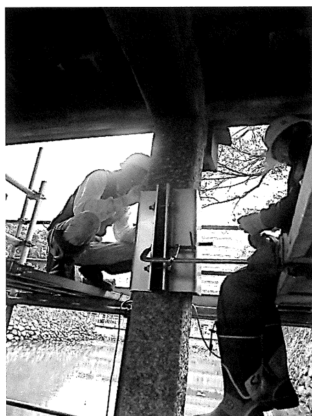
写真64 クラック箇所補強用ステンレス板 施工作業状況
