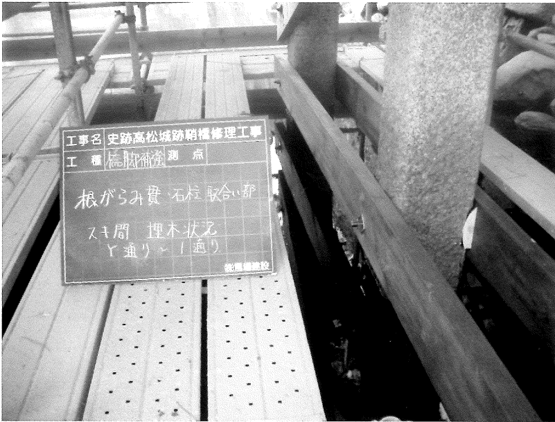
写真66 根がらみ貫設置状況
