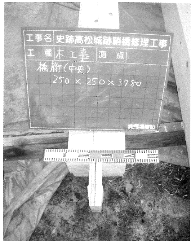
写真30 橋桁継手(中央既存部側端部:腰掛け鎌継ぎ)
