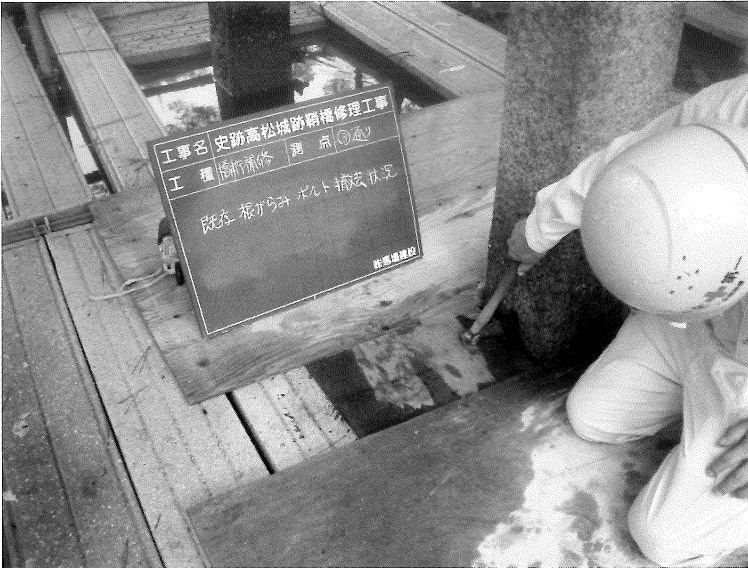
写真21 既存根がらみ貫固定ボルト撤去状況
