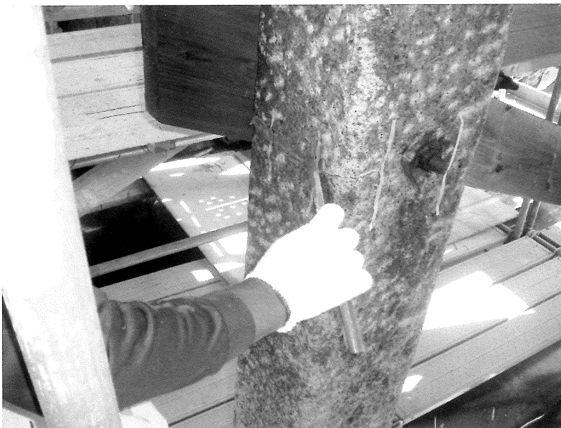
写真58 手動式エポキシ注入箇所 樹脂モルタル塗布
