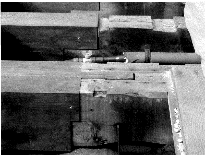
写真35 橋桁（中央）既存側継手部施工状況
