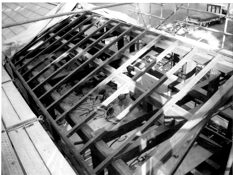
写真4 5 母屋・垂木施工状況
