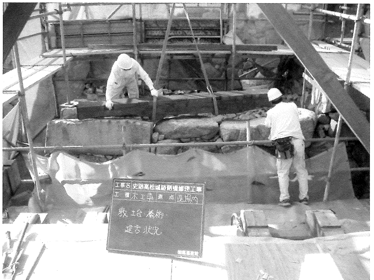
写真26 敷土台設置状況
