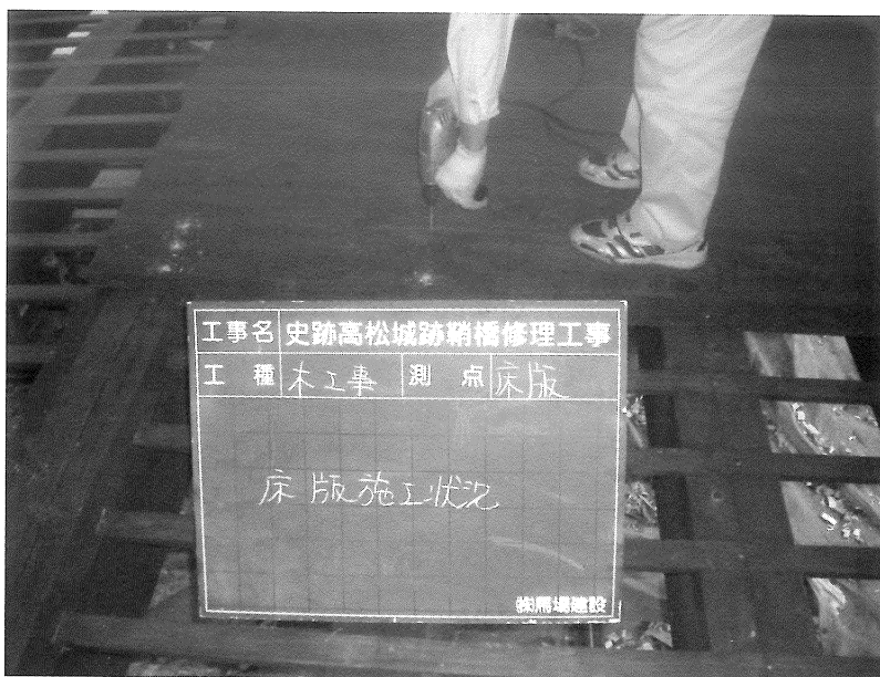
写真 5 2 床版施工状況
