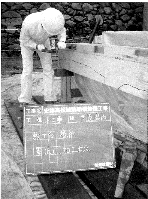
写真27 敷土台ひかり付け加工状況
