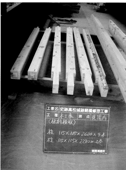
写真41 柱材（全て新材）
