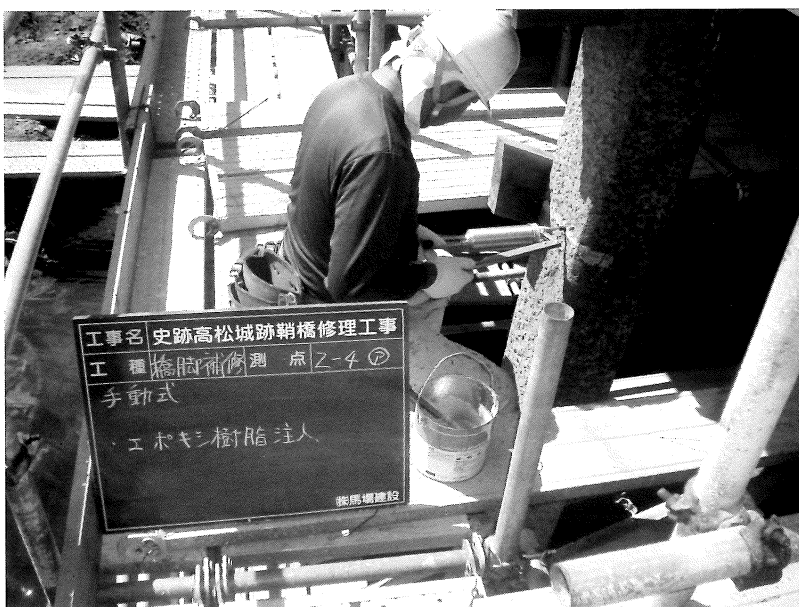
写真59 手動式エポキシ注入作業状況
