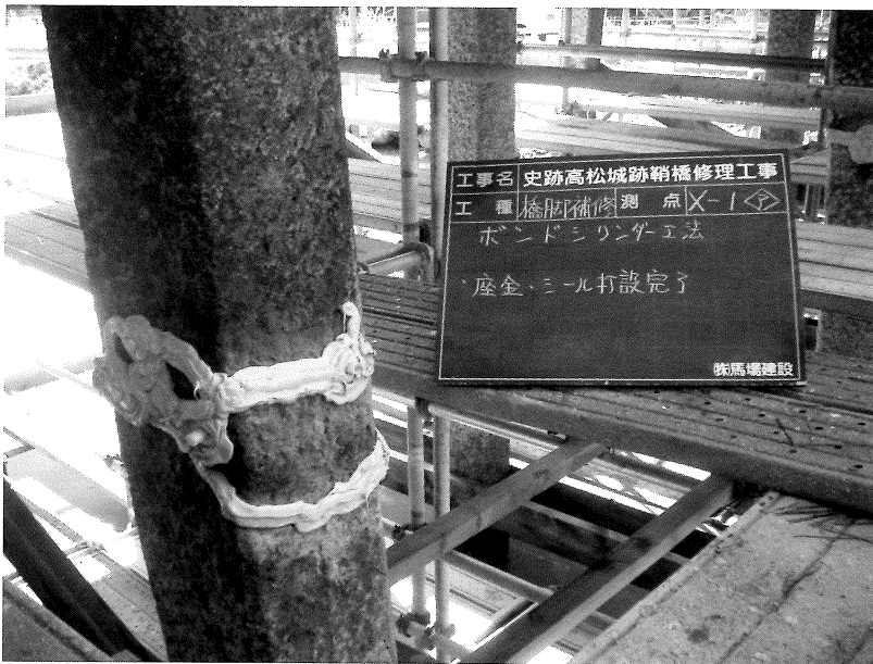
写真61 ボンドシリンダー工法 座金設置・シール打設状況
