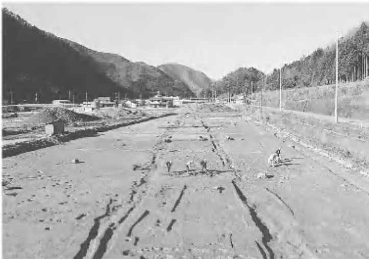
写真30 道路遺構調査風景（南から）
