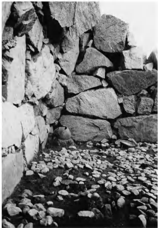
3 東側壁持ち送り状況 (北から)
