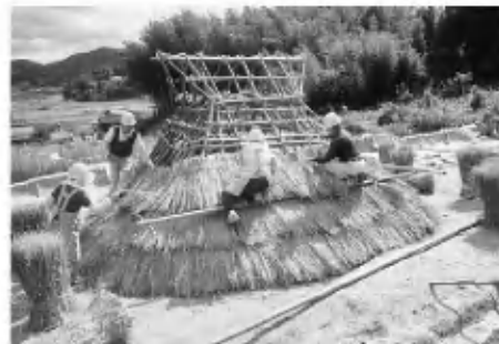
写真3 竪穴住居復元作業状況
