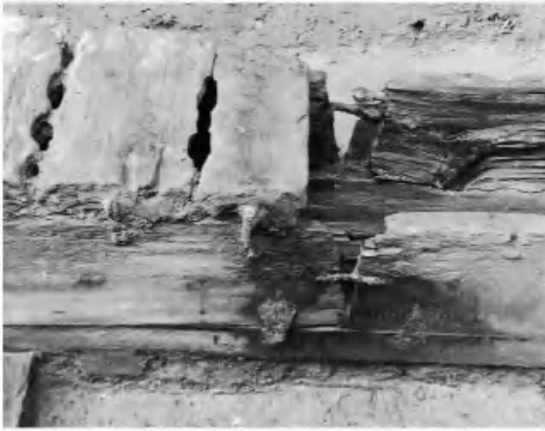
1 木樋管側板接合部（側板5・6）
