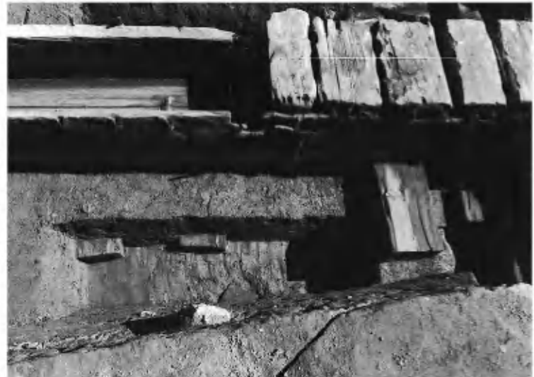
3 トレンチ7基礎枕木検出状況（西から）
