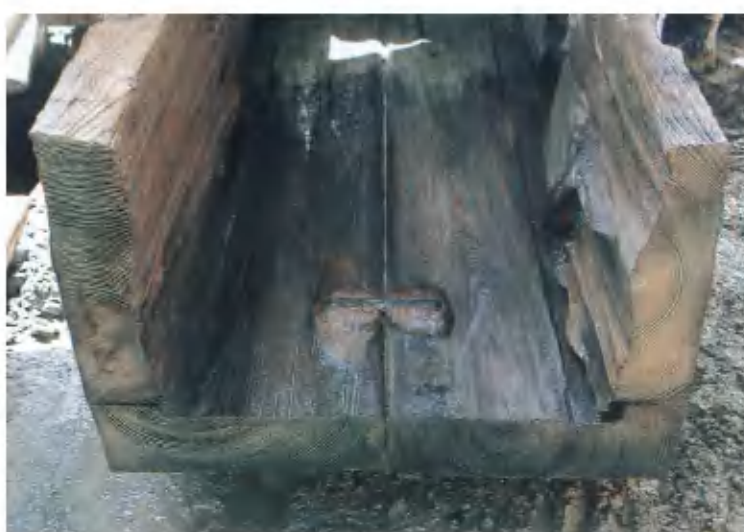
3 木樋管切断面（側板 6・底板 4）（北から）
