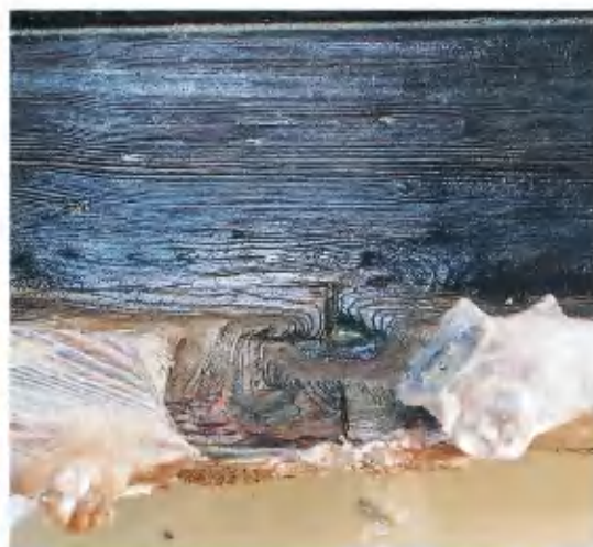
2 側板接合部（西側板 3・4）
