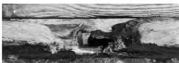
4 側板接合部（西側板4・5）
