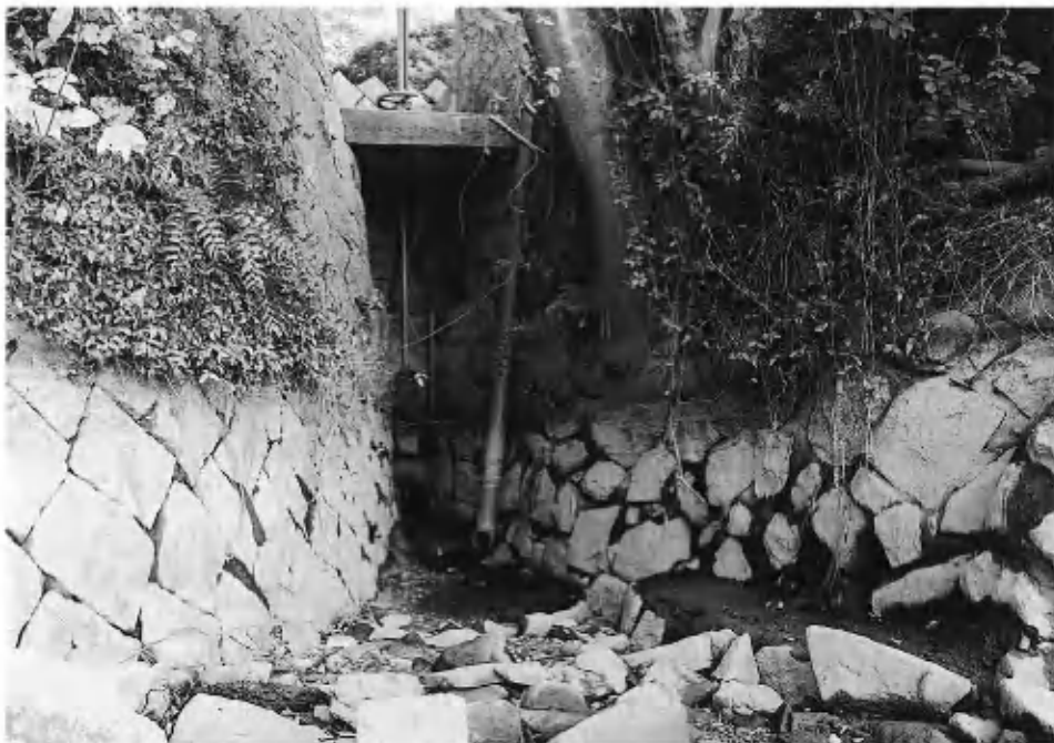
写真1 花交の池排水樋門（旭川側、南から）
