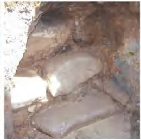
2 旧排水路東側護岸石積 検出状況 (北西から)
