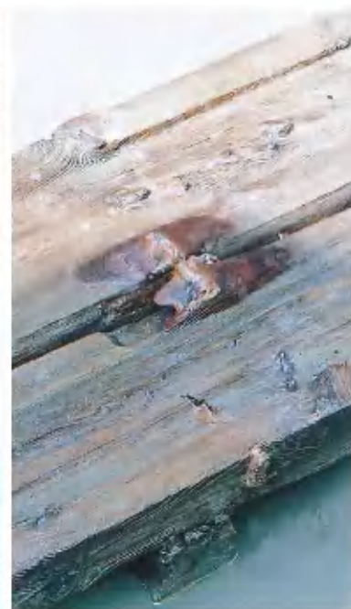
6 底板 1 板材接合状況（南東から）
