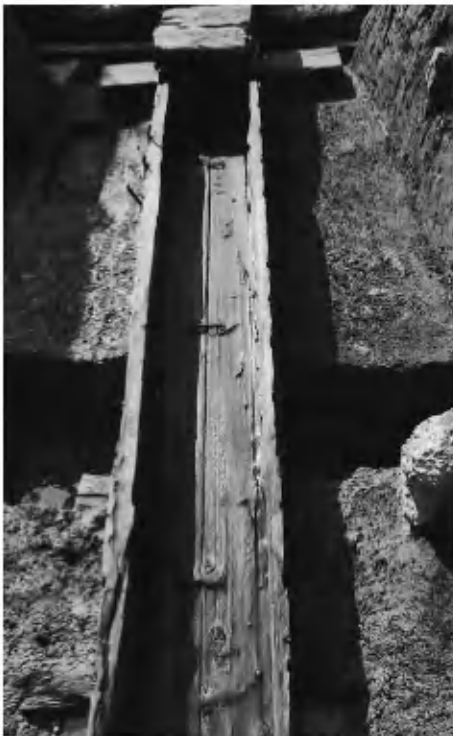
1 木樋管側板接合部（側板5・6）
