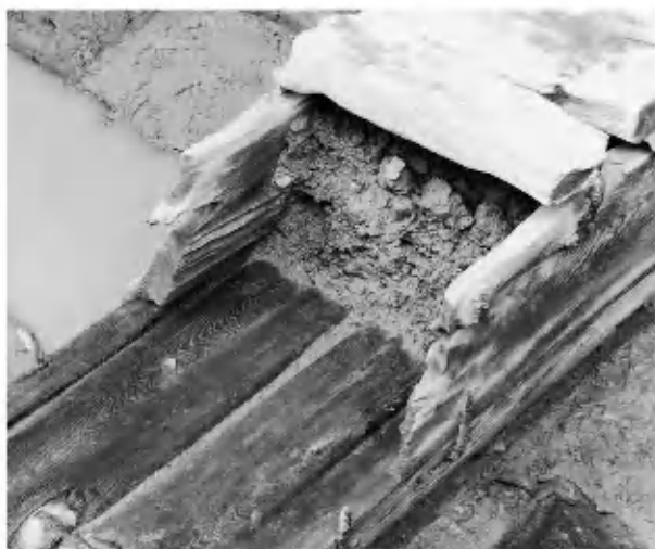
1 木樋管側板3南木口（南東から）
