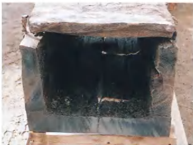
1 木樋管切断面（側板 4・底板 2）（北から）
