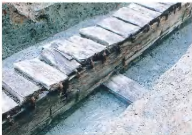
4 木樋管中央部西側面（北西から）
