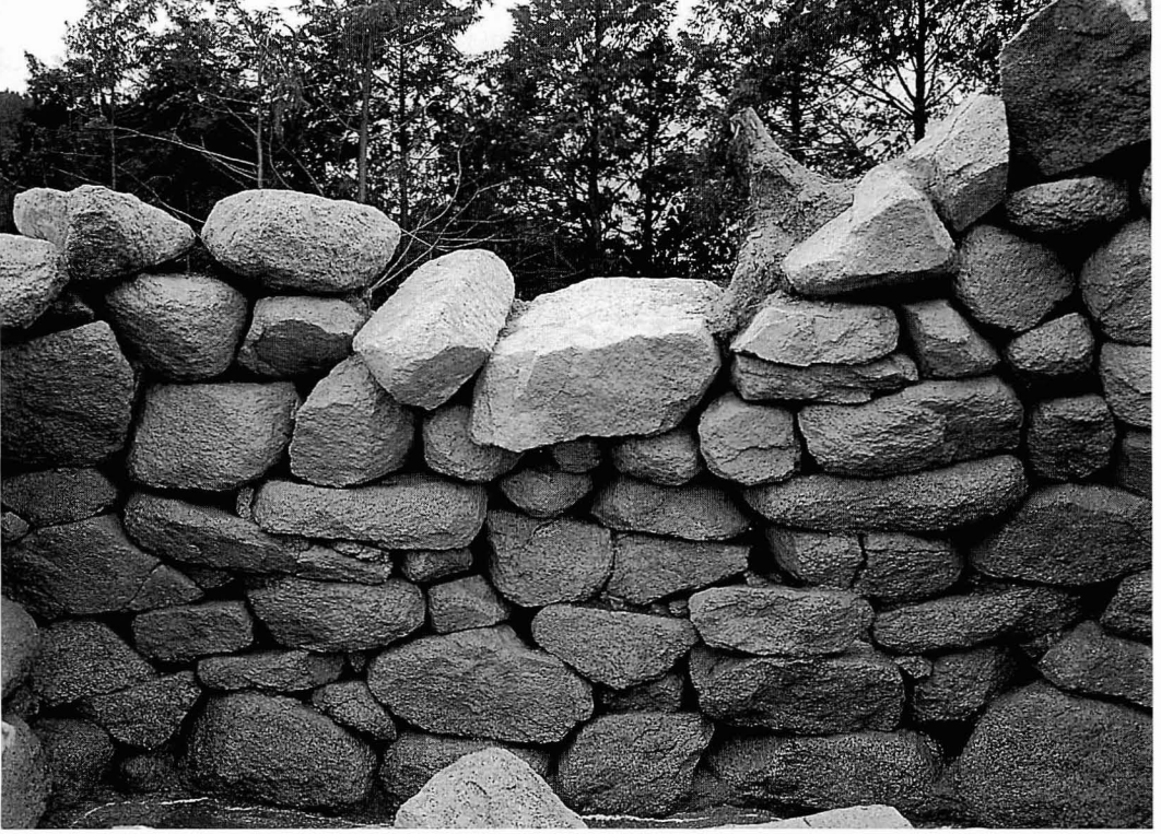
巨勢山408号墳 石室（玄室右側壁）
