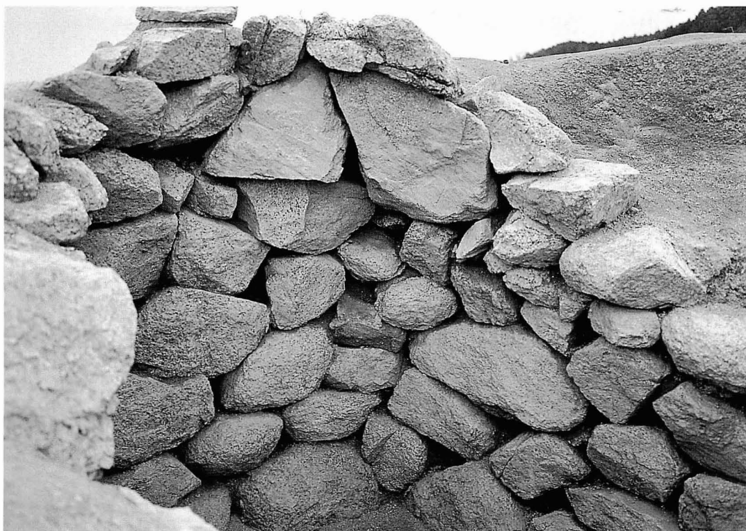
巨勢山407号墳 石室（奥壁と左側壁のコーナー部分）
