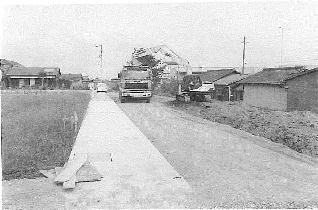
第3 トレンチ重機稼働状況
