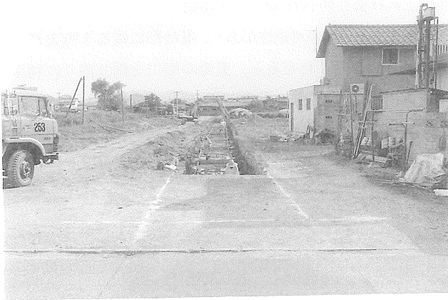
第2 トレンチ全景（調査終了後）
