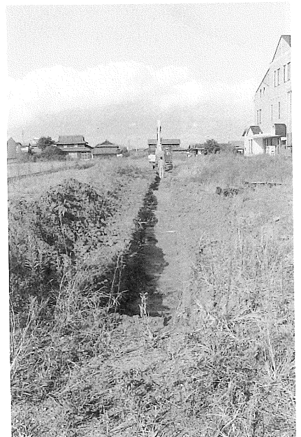
第5 トレンチ完掘全景
