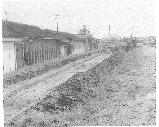
第3 トレンチ完掘全景
