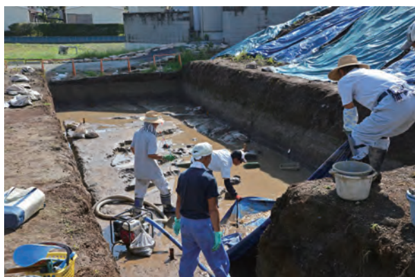
第2調査地点湧水発生状況
