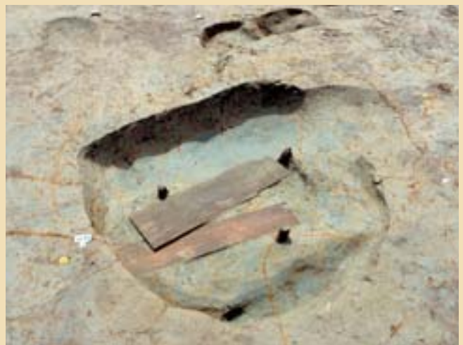
建物の柱の沈み込みを防ぐためとも考えられる板が底面に敷いてあり、3ヶ所を杭で押さえています。
