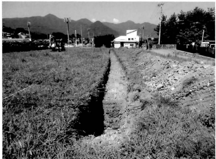
1号トレンチ完掘状況 (東より)
