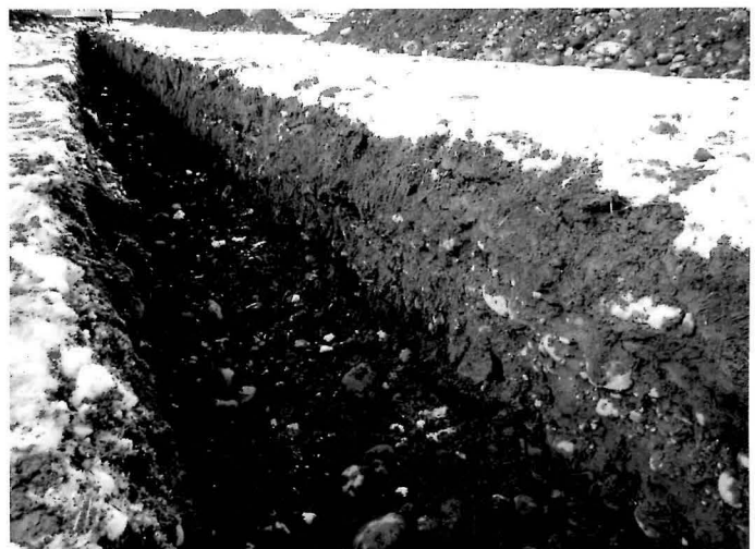
トレンチ完掘状況 (南東より)
