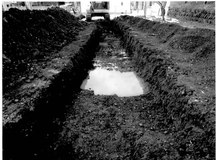
トレンチ完掘状況 (東より)
