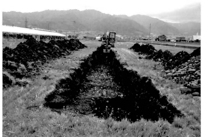
トレンチ掘削状況 (西より)
