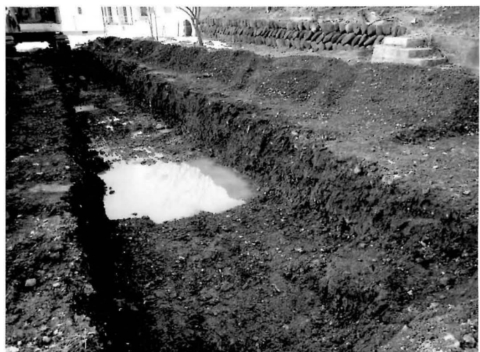
トレンチ完掘状況 (南東より)
