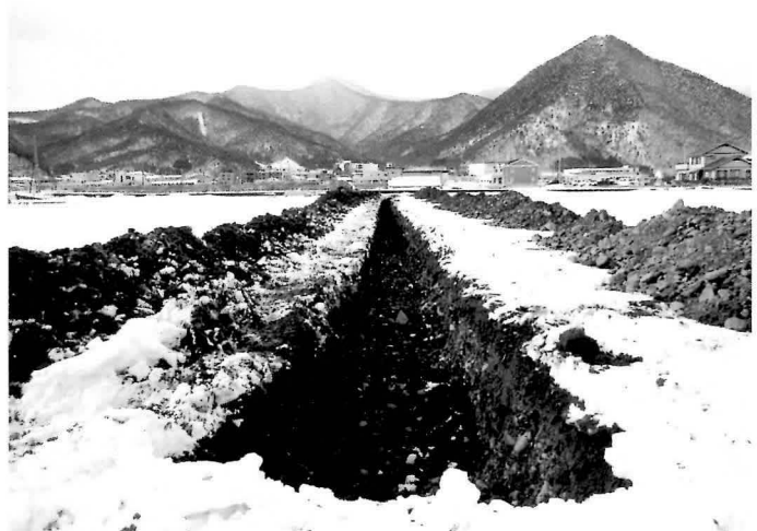
トレンチ完掘状況 (東より)
