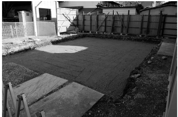
13 調査区埋戻し後（南西から）
