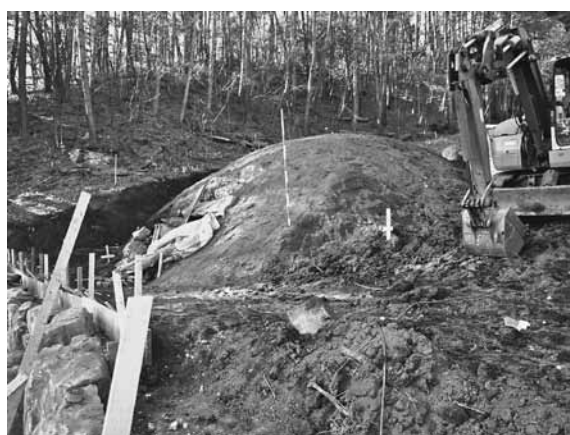
4 古墳保存復元工事（4）
