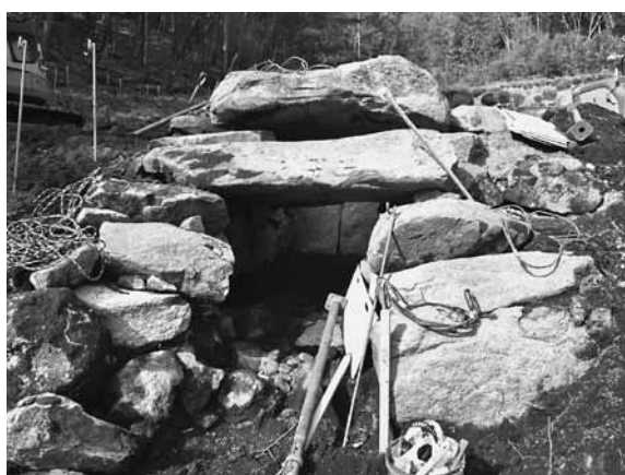
3 古墳保存復元工事（3）
