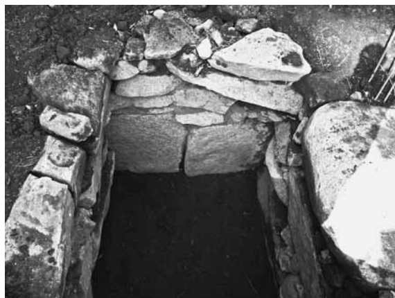
2 古墳保存復元工事（2）
