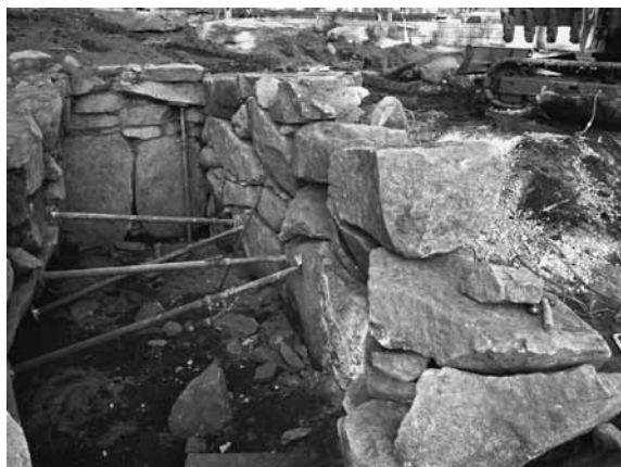
1 古墳保存復元工事（1）
