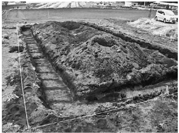
図版 24 完掘全景(北東から)
