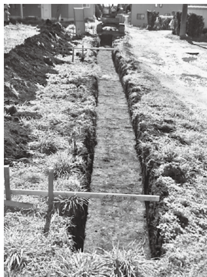
図版25 トレンチ掘削状況(北から)
