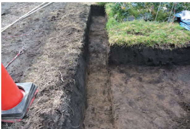
Fig.14 サブトレンチ（東から）
