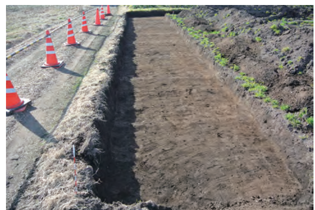
Fig.13 東西トレンチ（東から）
