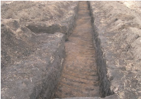
2 トレンチ 1 南から
