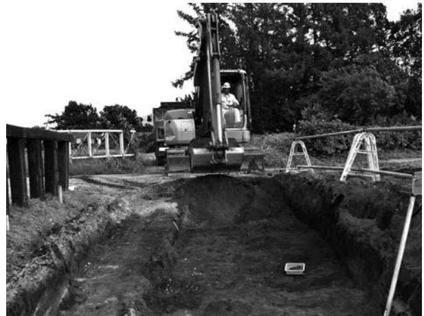
重機による表土剥ぎ
