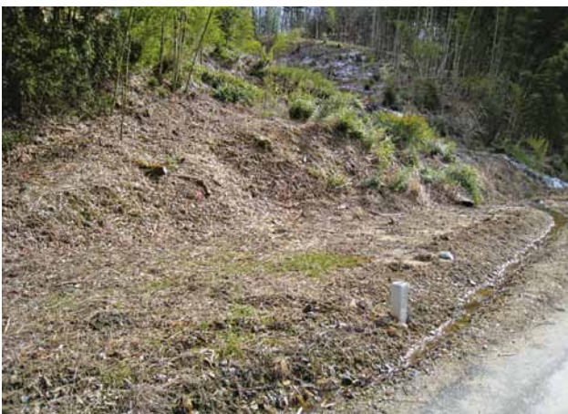
玉川側の崖 調査前風景（北西から）
