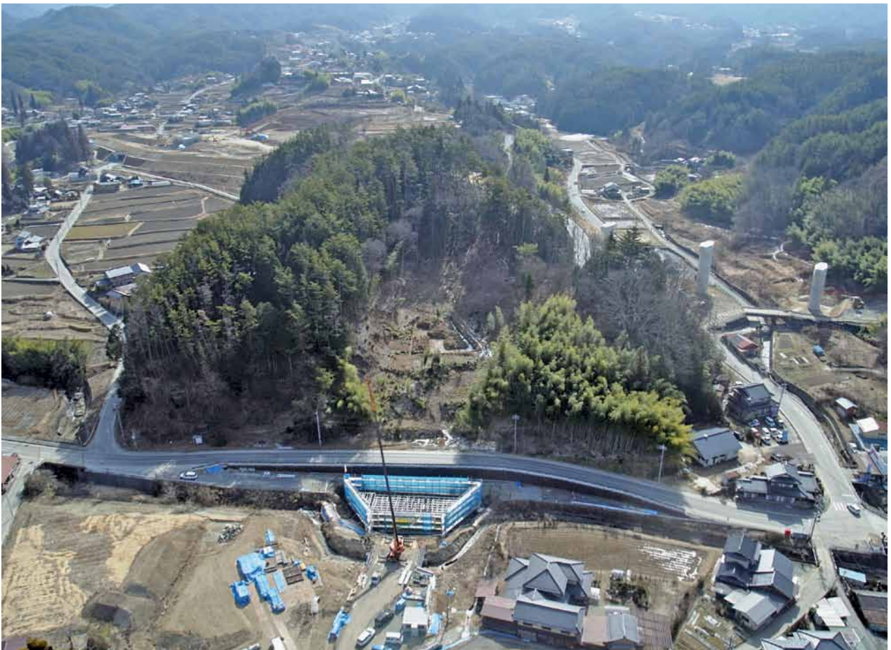
試掘後の龍源寺跡 遠景（北西から）
