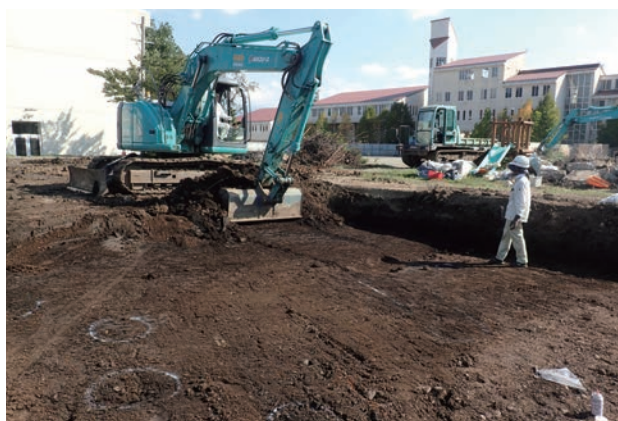
重機による表土掘削
