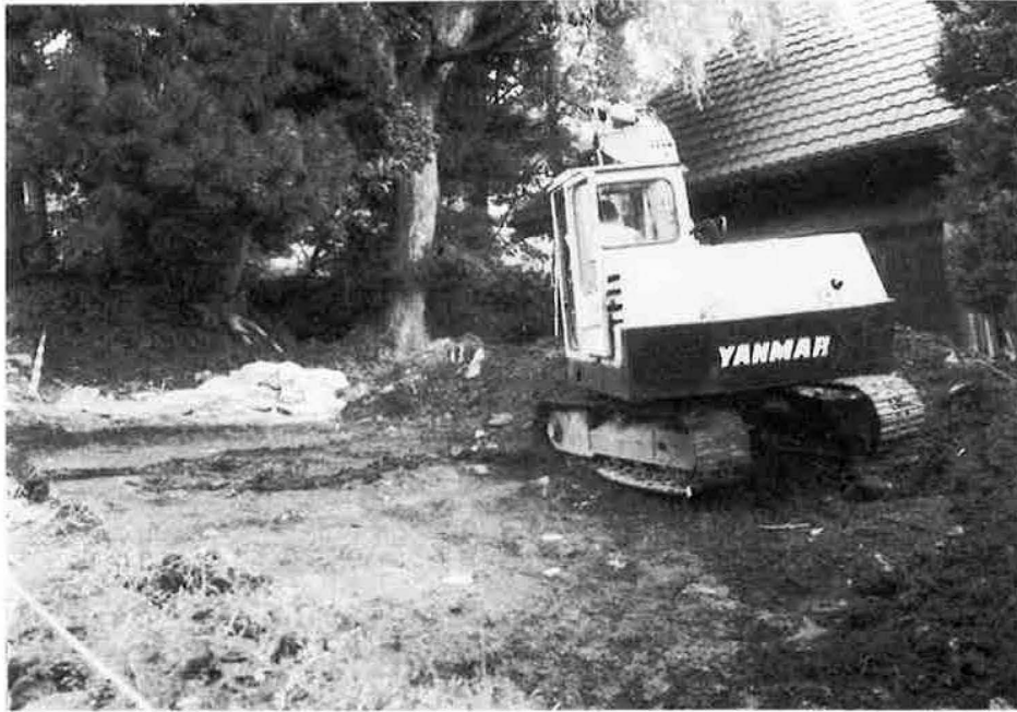
写真3 重機による表土除去
