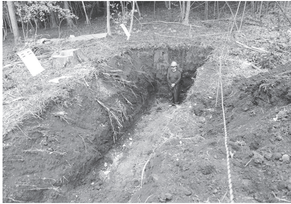
第34トレンチ 南東から
