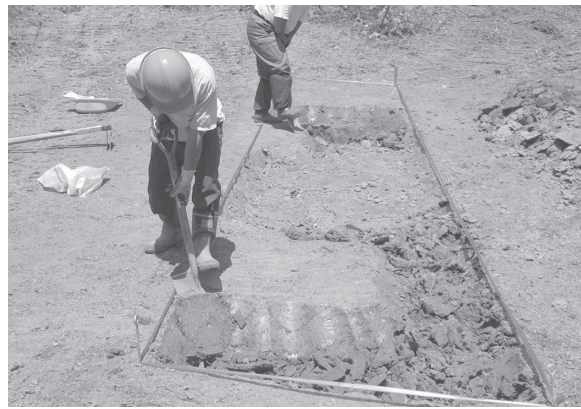
人力掘削作業(1)
