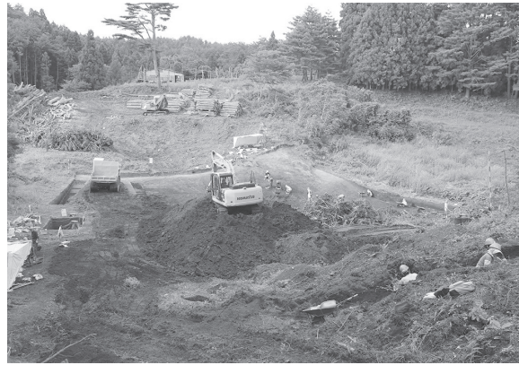
重機掘削状況 南から
