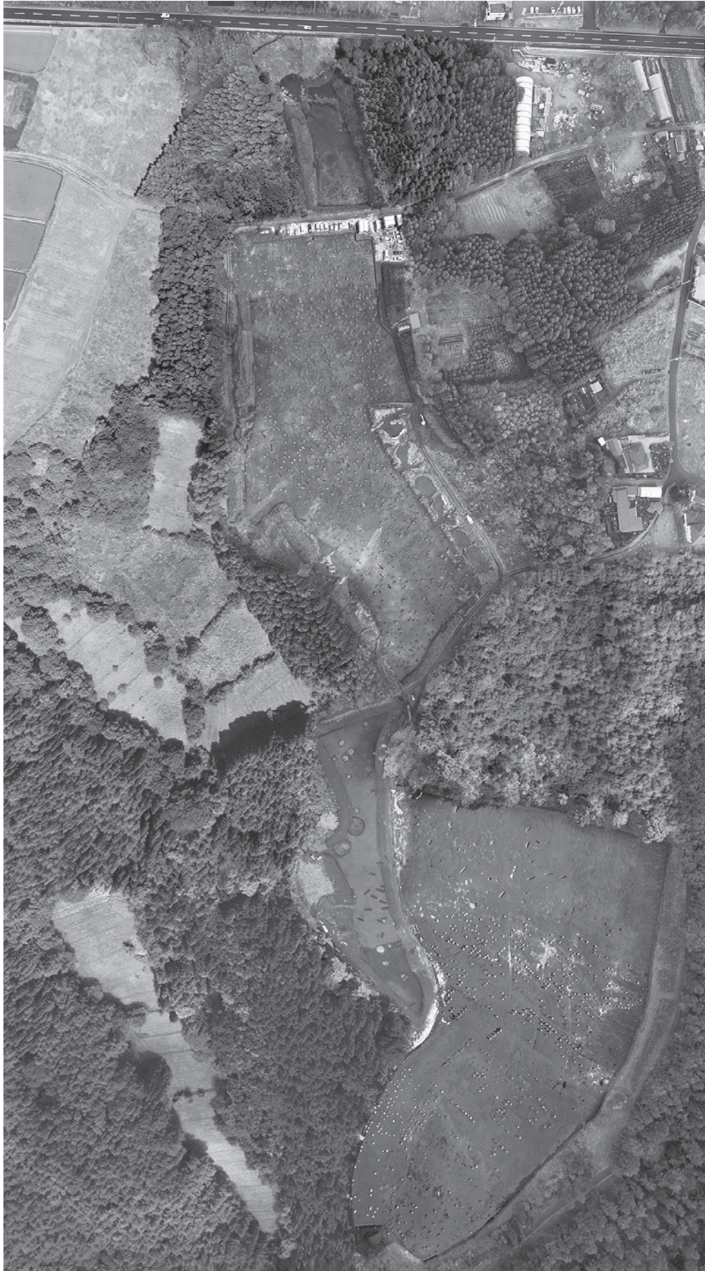
平成 11 ～ 13 年度 ・ 平成 23 ～ 25 年度調査区全景
