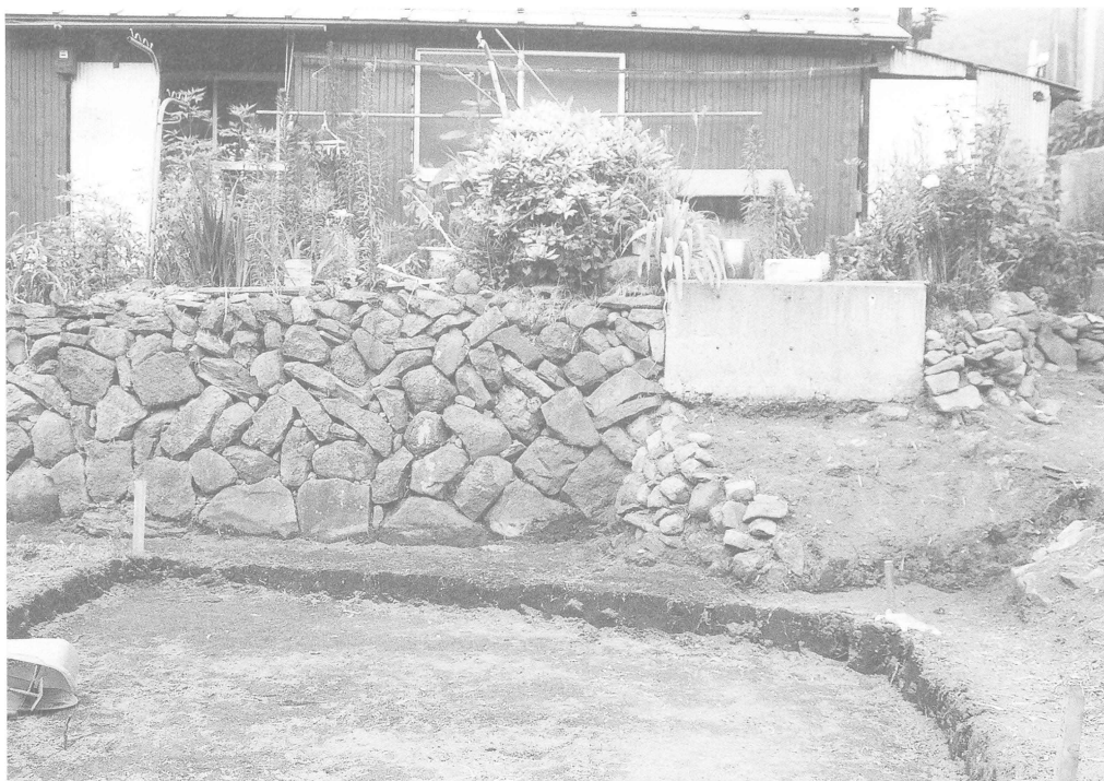
家屋前の石積み状況（南から）
