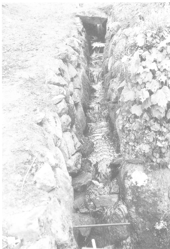
調査区内水路の石積み
