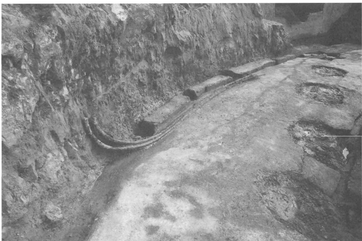
写真6 4 a コンクリート舗装スロープ上の通信ケーブル
