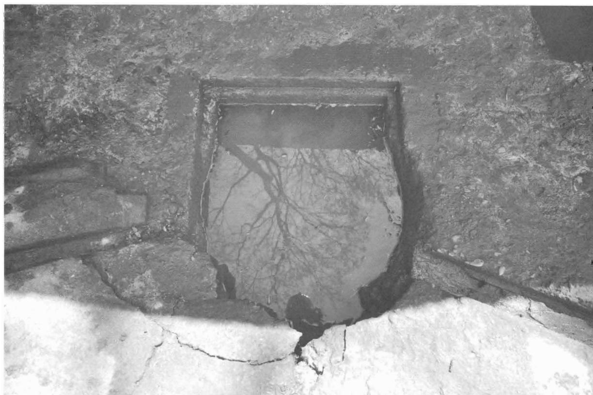
写真8 4.aコンクリート舗装スロープ集水枠
