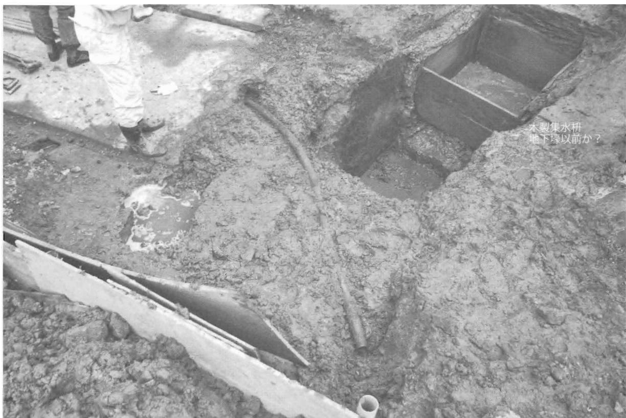
写真5 4 a コンクリート舗装下 上水道管
