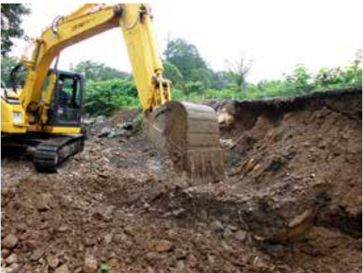
写真121 作業風景(W→)
