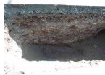
写真86 トレンチ1 (W→)
