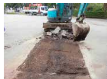
写真153 掘削状況(N→)
