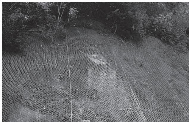
写6 岸壁上部の剥落
