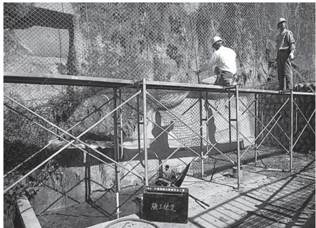
写35 平成24年度保全工事 落石防護ネット設置
