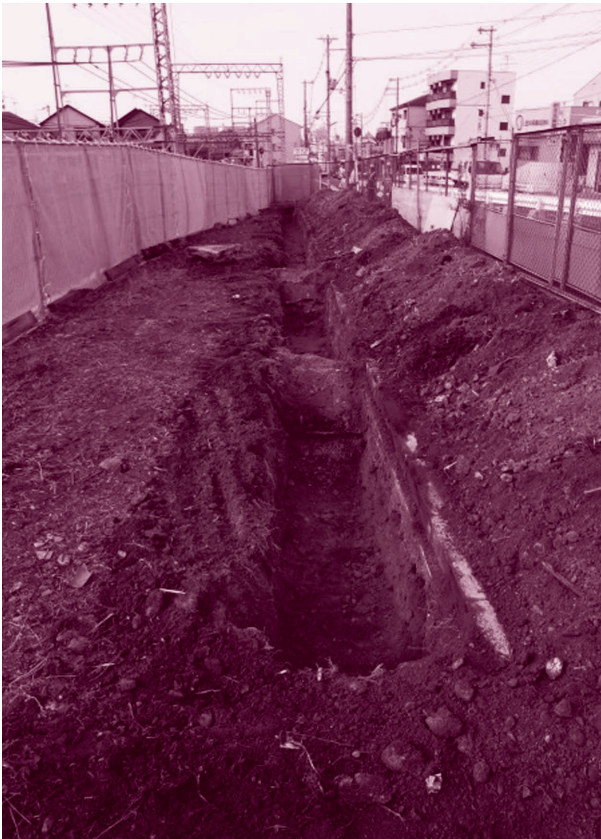
23-2区東部全景(東から)
