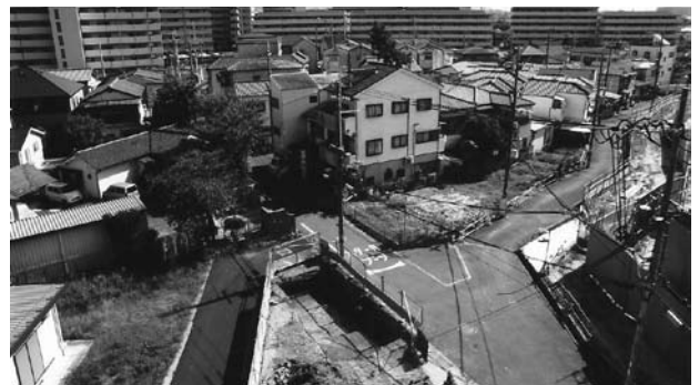
図15 招提中町遺跡第1区(北から)
