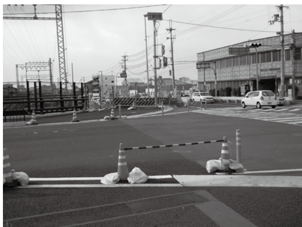
図50 土師ノ里交差点全景
