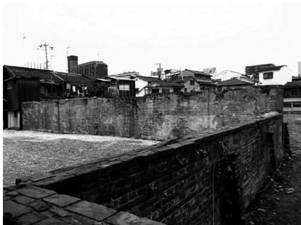
図71 煉瓦塀の状況(南東から)
