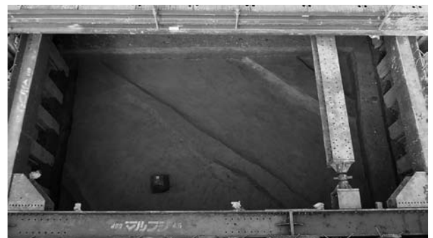
図5 第2工区4面全景
