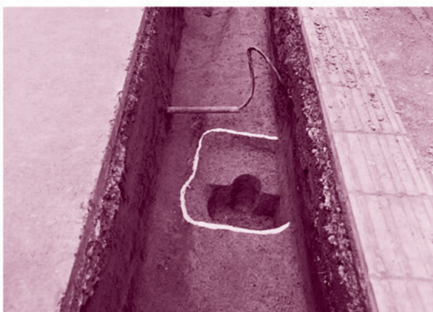
9区 SP06 掘削状況（西から）
