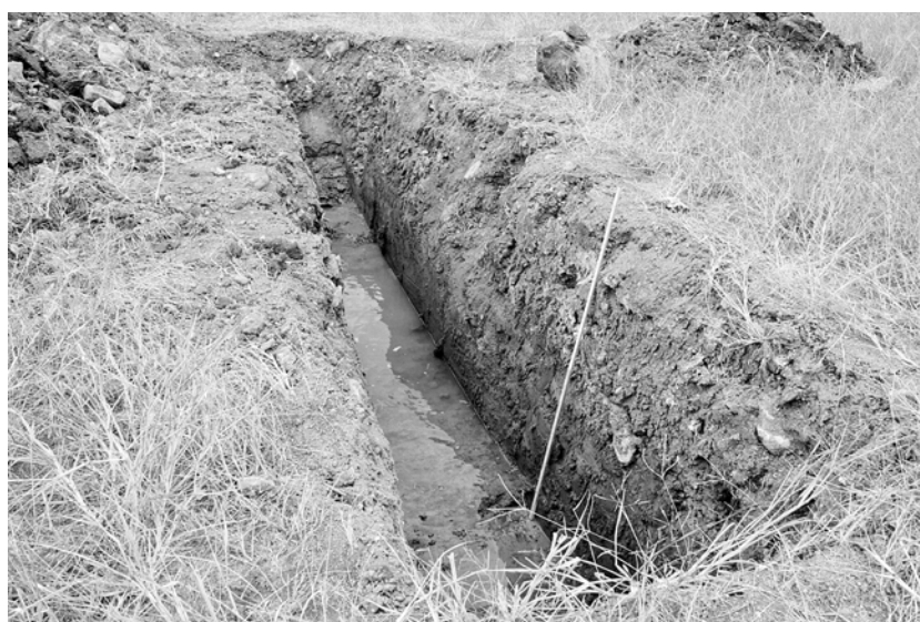
写真1 トレンチ状況
