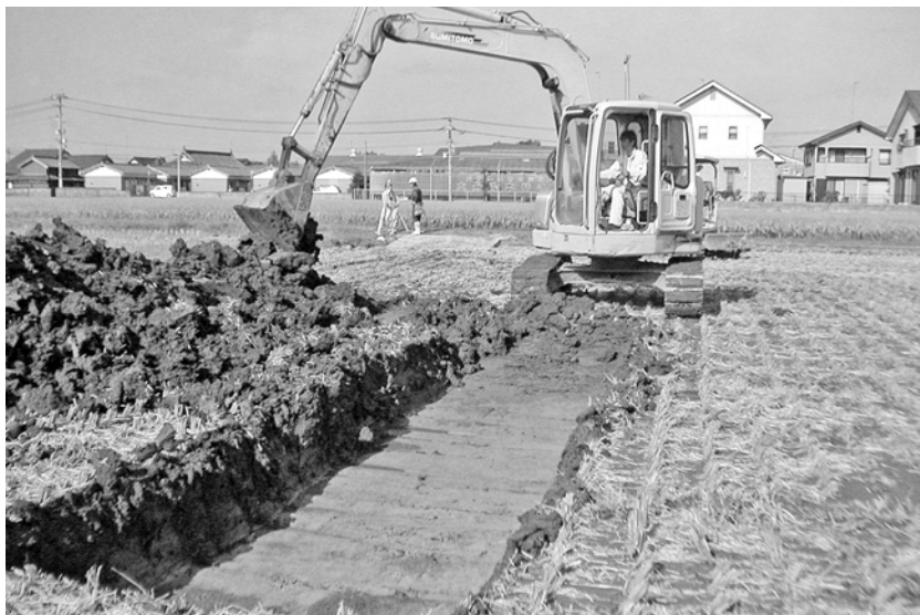
写真2 トレンチ掘削状況
