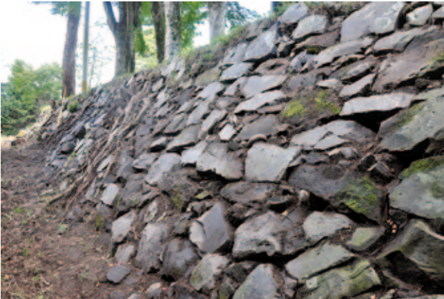
写真9 9面築石清掃後
