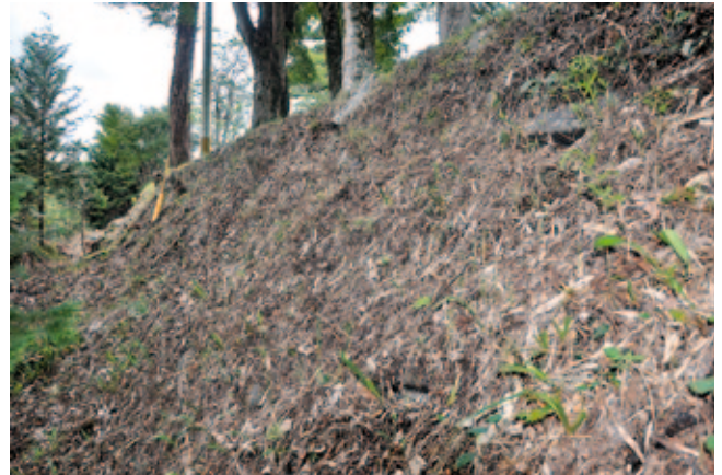
写真10 9面築石清掃前
