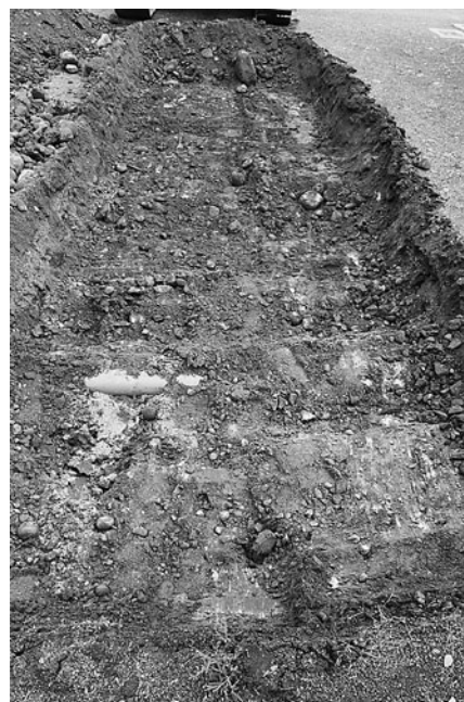
写真25 トレンチ掘削状況
