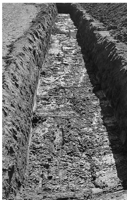
写真21 トレンチ掘削状況
