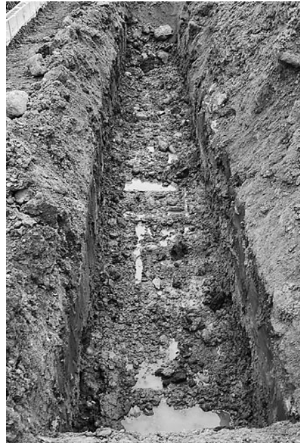
写真22 トレンチ掘削状況
