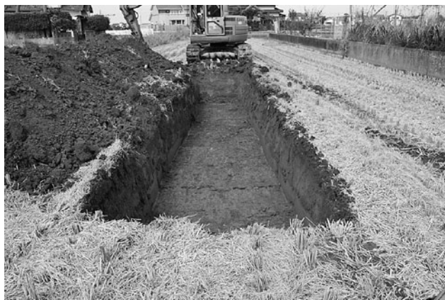
写真24 トレンチ掘削状況
