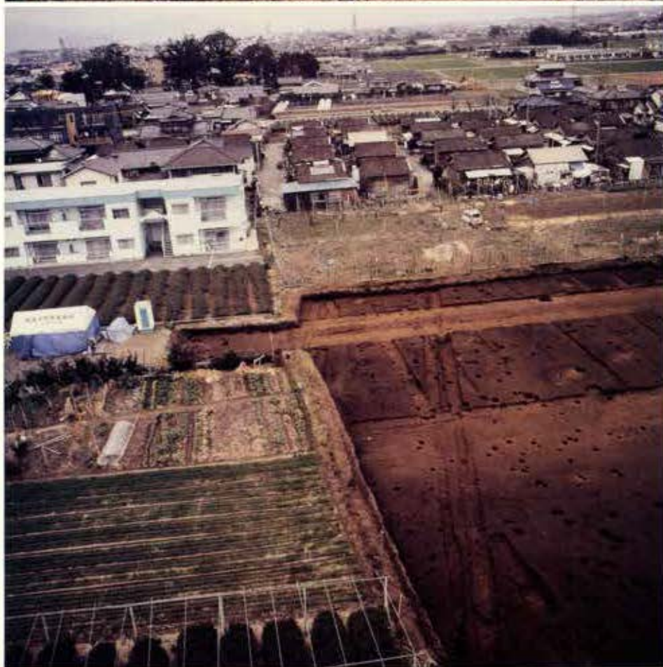
道路状遺構完結状況 （空中写真：南から）
