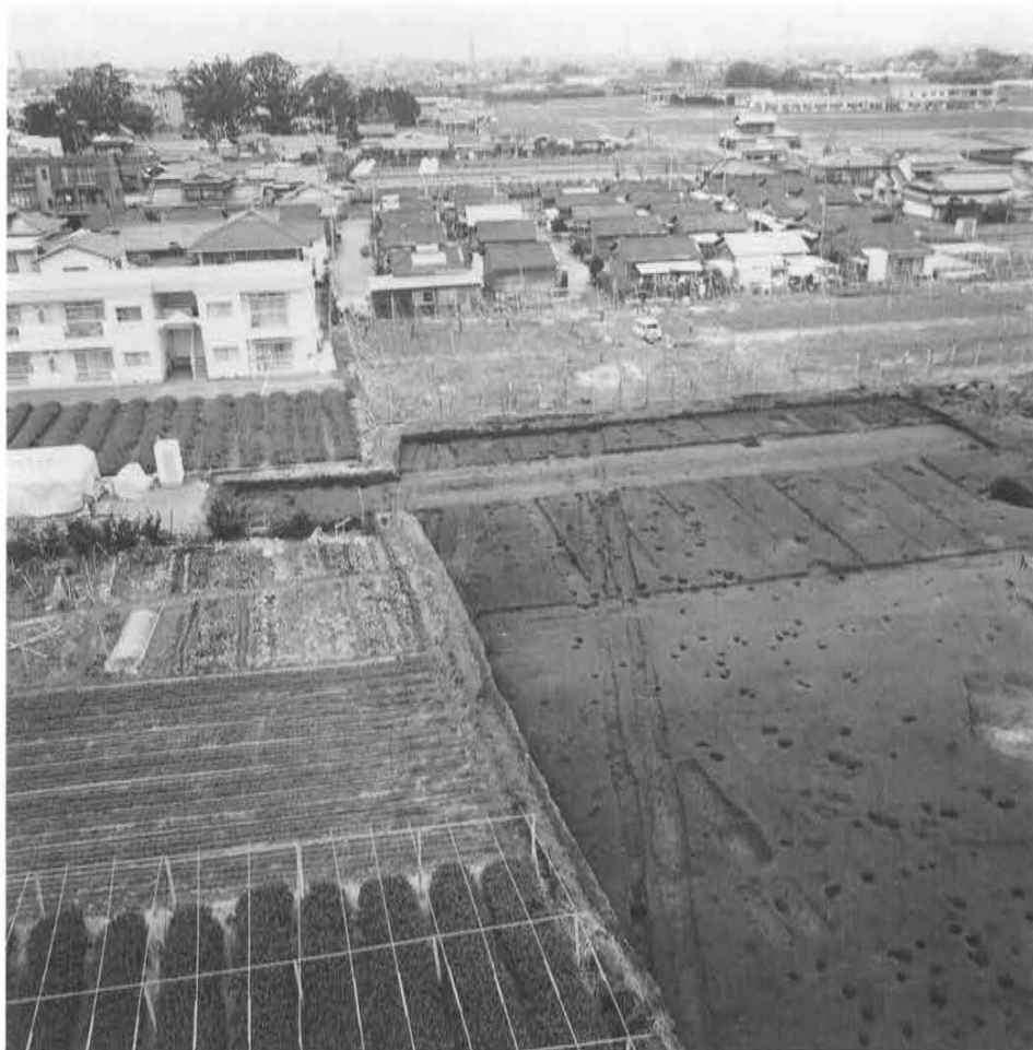
鶴田中市ノ塚遺跡（第1次調査）道路状遺構（空中写真：南から）
