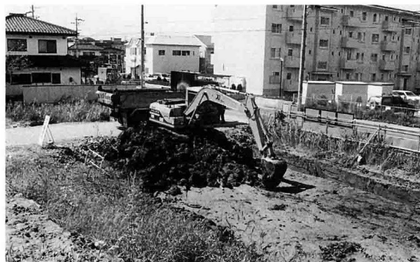
重機表土剥ぎ
