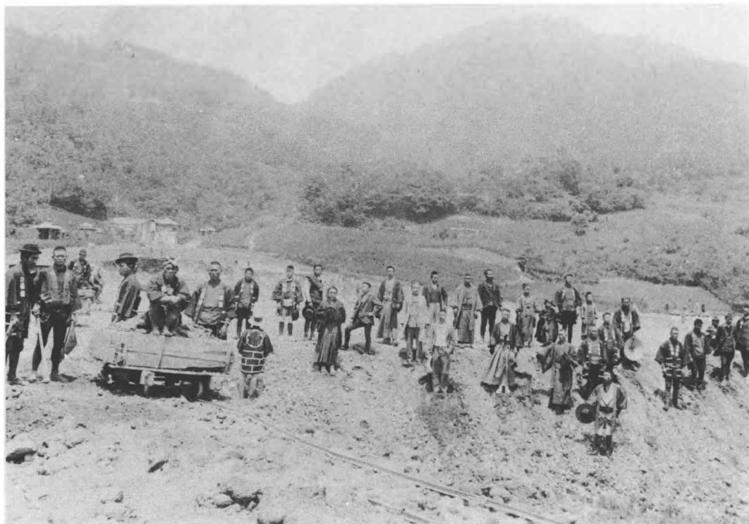
長野高女造成工事（明治34年）
