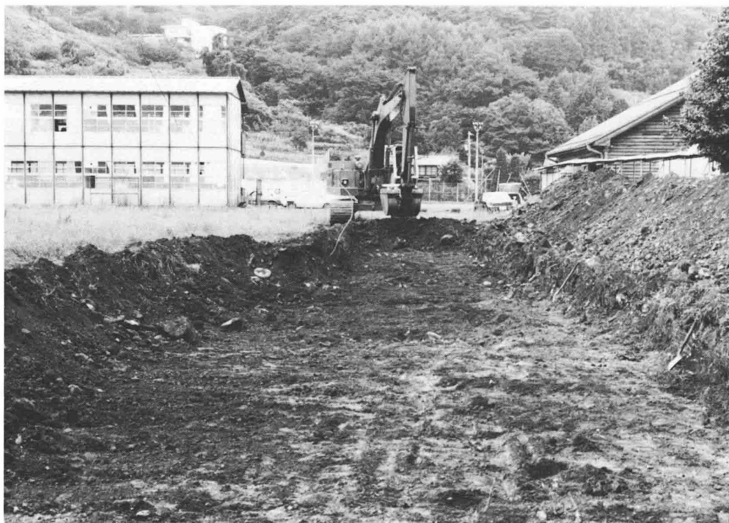
調査区表土除去
