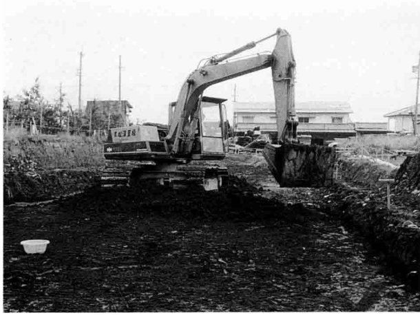
重機表工剥ぎ
