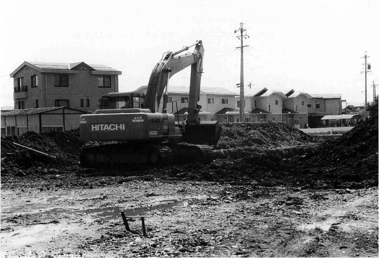
重機稼動状況
