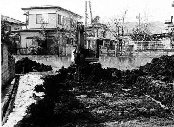
写真1 重機表土掘削
