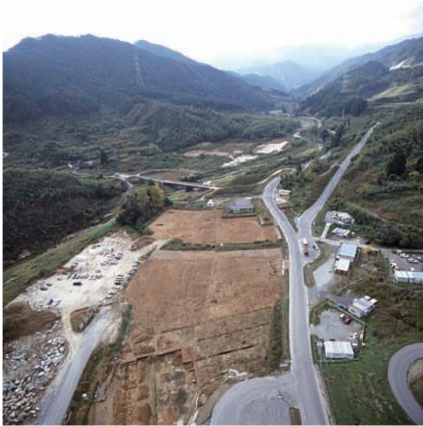
5 N・5 S区遠景（北から）
