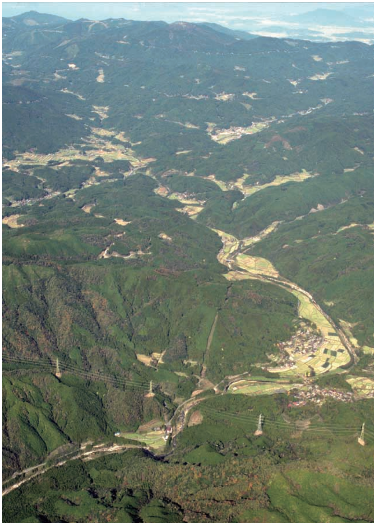
嘉瀬川ダム予定地中心部（南東から）（平成4年10月撮影 嘉瀬川ダム工事事務所提供）
